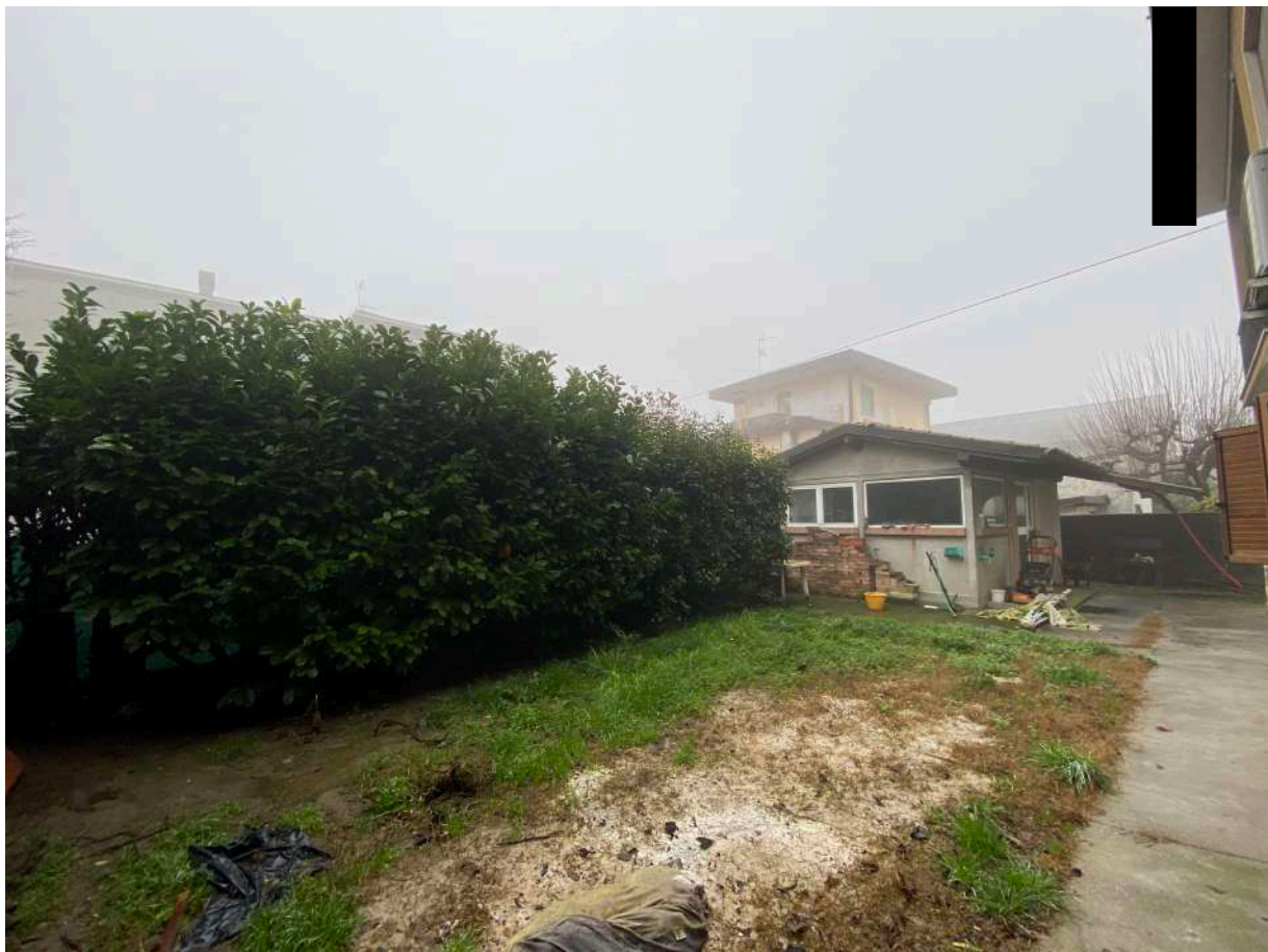
Foto 05: FABBRICATO ESTERNO AD USO DEPOSITO
