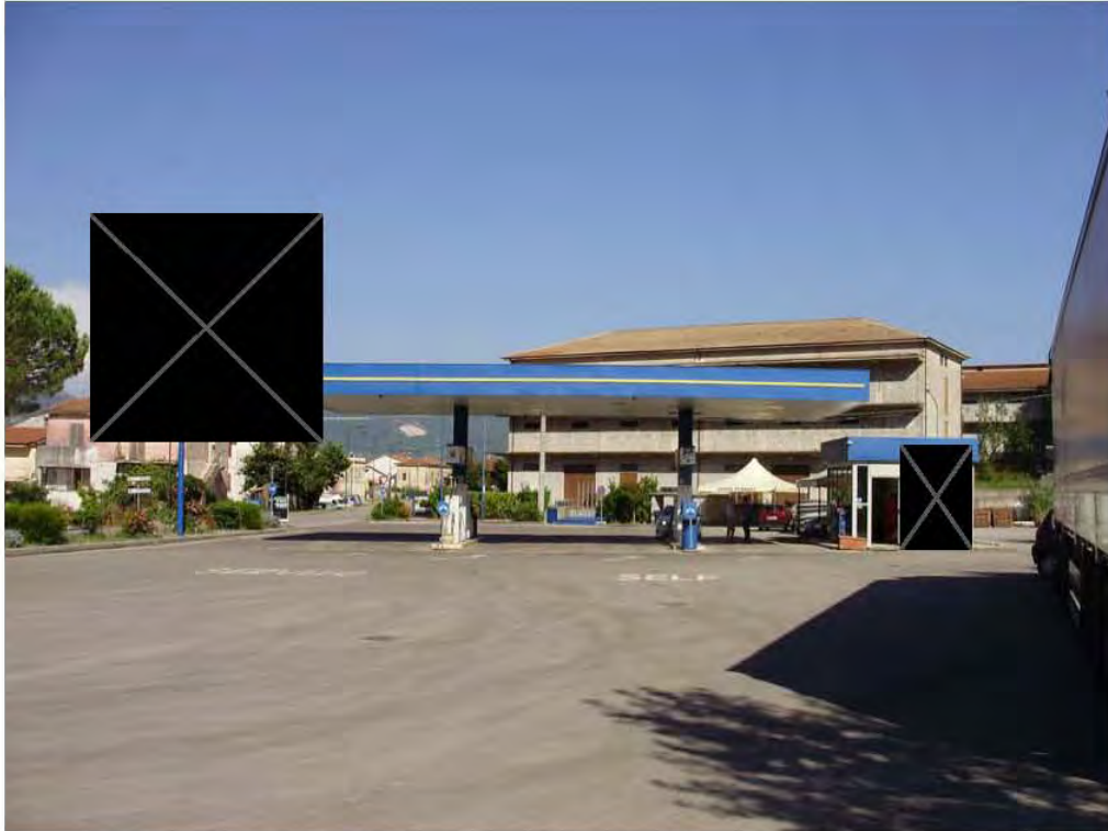
Foto n. 1 –impianto di distribuzione carburanti e lubrificanti
