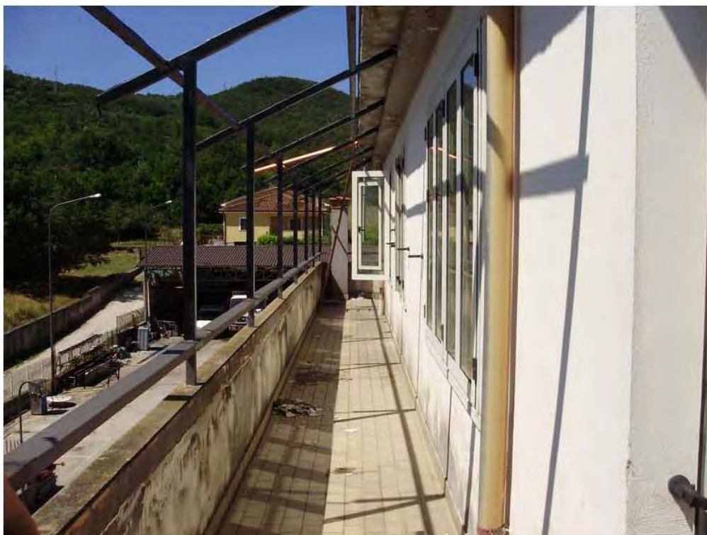
Foto n. 9 – terrazza al secondo piano
