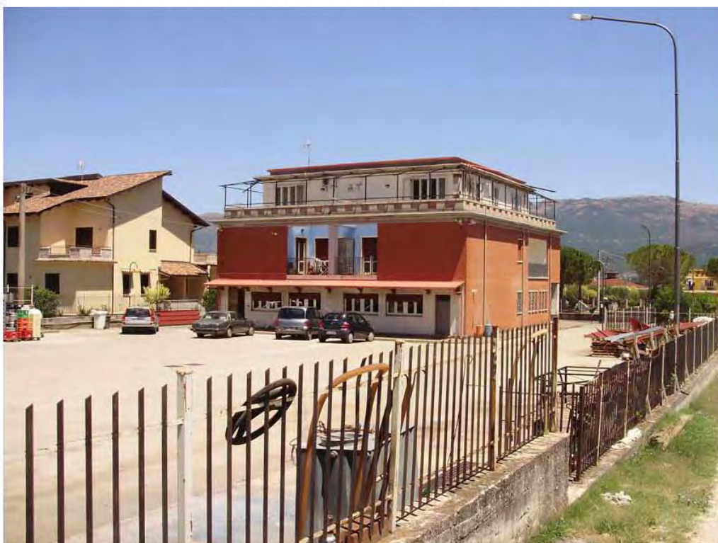
Foto n. 2 – prospetto sud ovest
