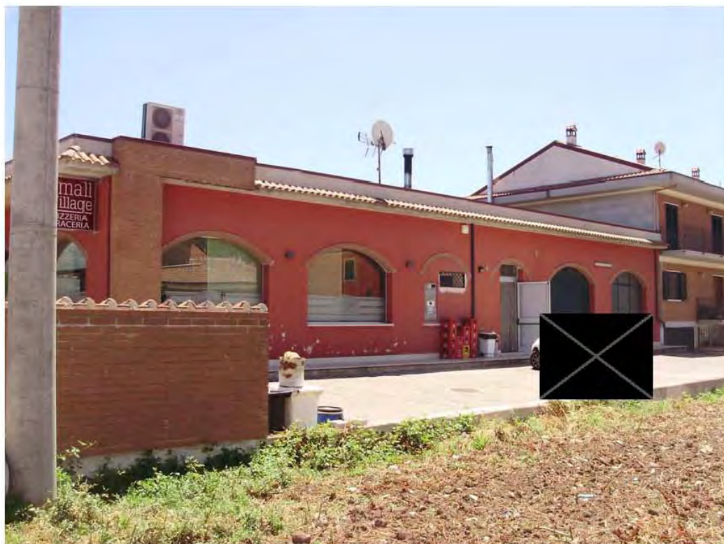
Foto n. 1 – prospetto ovest e accesso al locale
