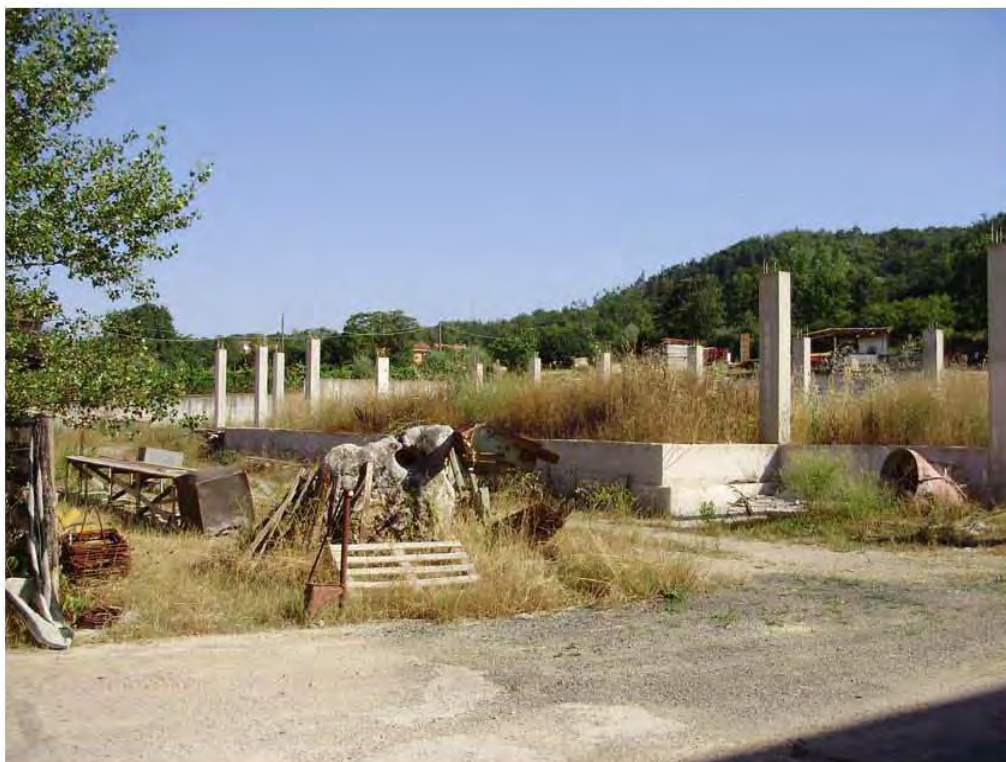
Foto n. 5 – fabbricato in costruzione sulle p.lle 714 e 719
