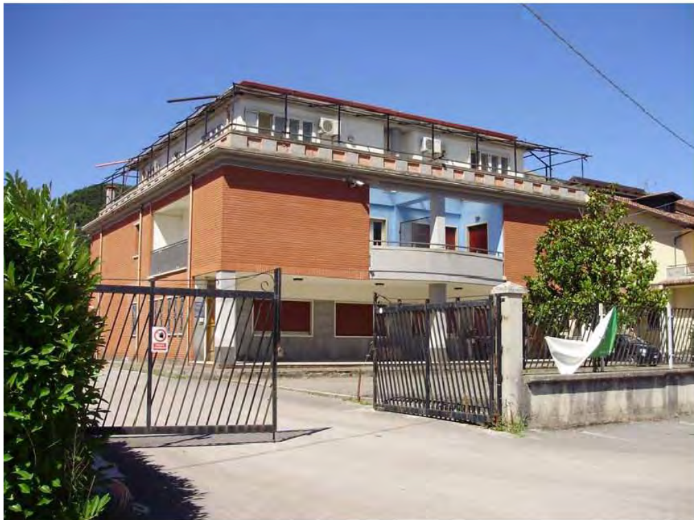
Foto n. 1- Ingresso principale dalla via Casone
