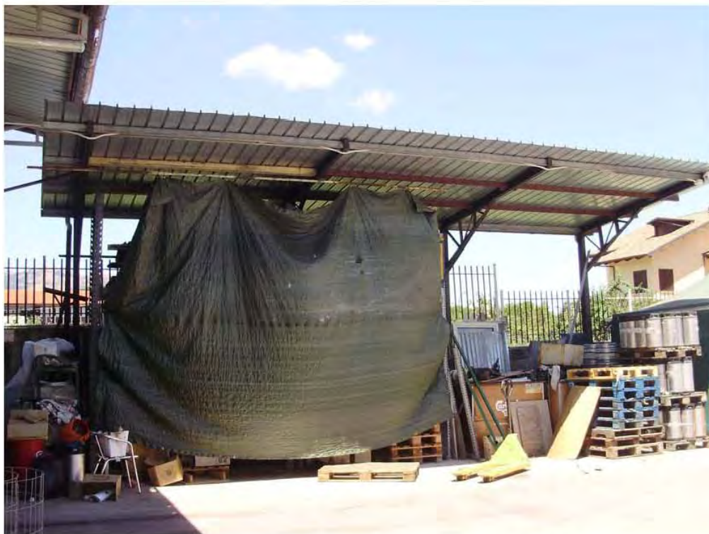
Foto n. 11 – tettoia abusiva costruita sulla corte del fabbricato
