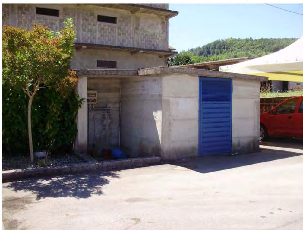
Foto n. 4 – casotto per ricovero compressore
