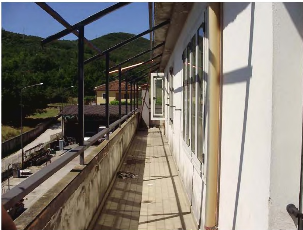
Foto n. 9 – terrazza al secondo piano
