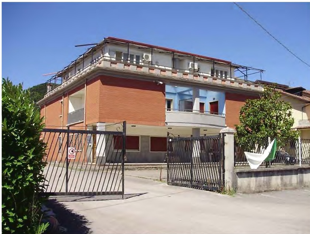
Foto n. 1- Ingresso principale dalla via Casone
