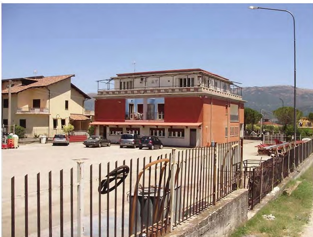
Foto n. 2 –prospetto sud ovest
