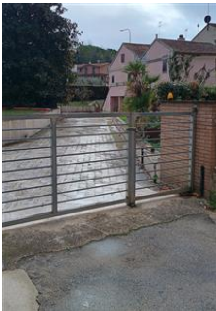
accesso al garage
