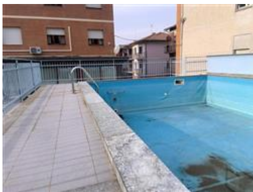
interno piscina su terrazzo
