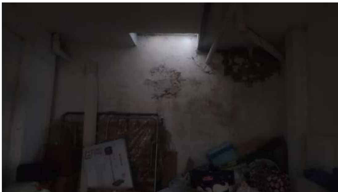
ALTRA VISTA INTERNA
