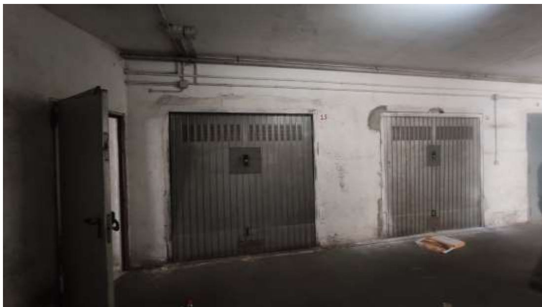
VISTA ESTERNA DEL BOX
