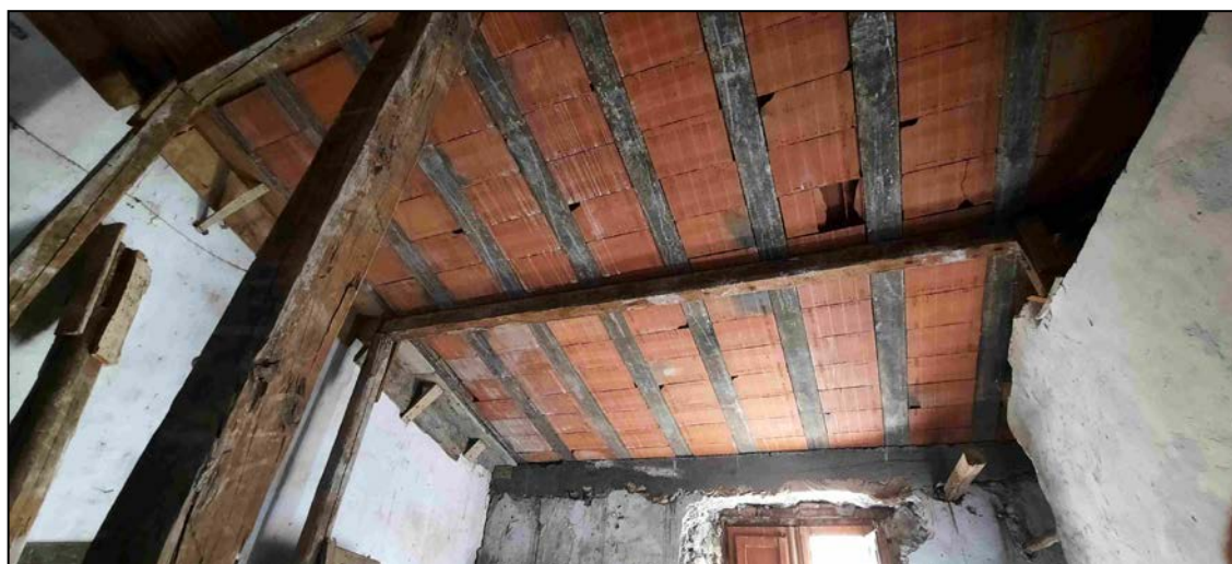
Copertura zona notte Secondo Piano
