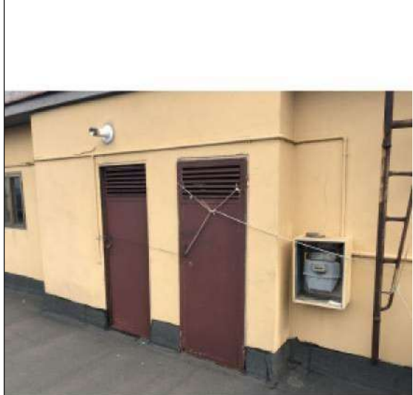
N. 11 - Locale Tecnico
