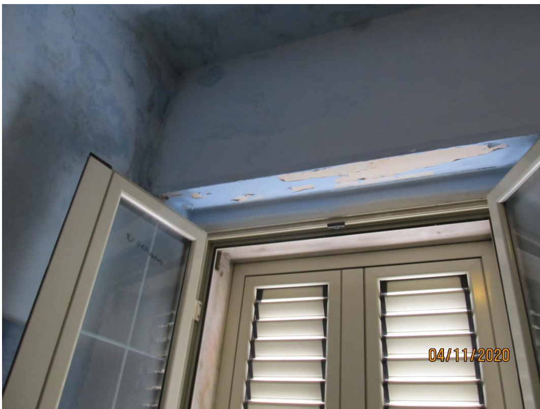
Figura 5 INFILTRAZIONI PROVENIENTI DALLA COPERTURA
