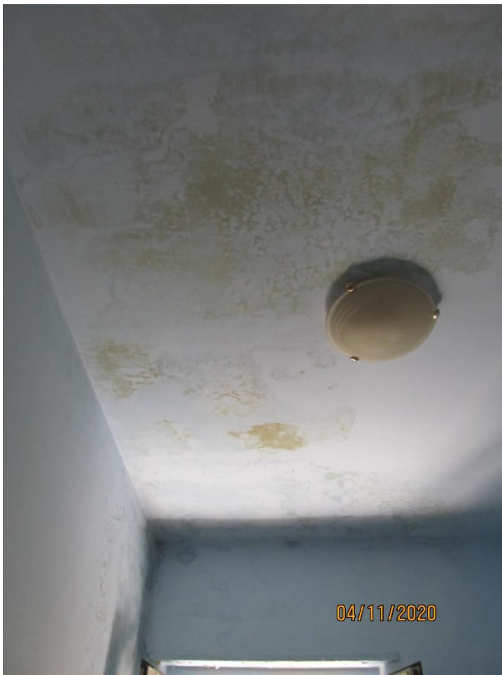
Figura 5 INFILTRAZIONI PROVENIENTI DALLA COPERTURA
