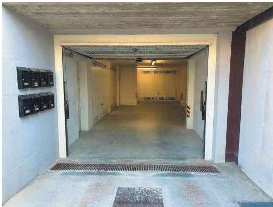
Ripresa 19 Accesso corsia comune garage piano seminterrato
