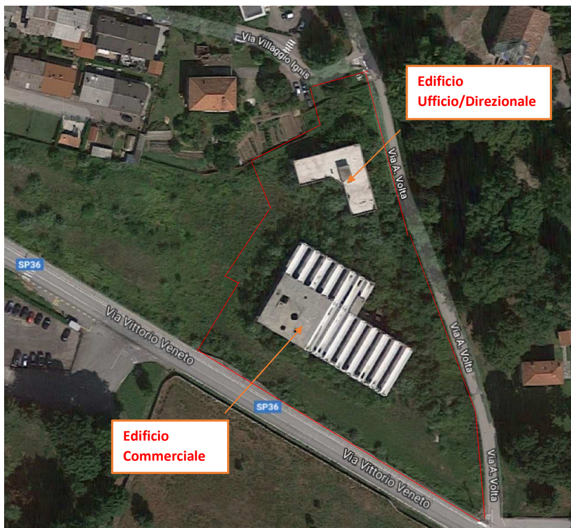
— Vista aerea del “Lotto B” sito nel Comune di Travedona - Monate (Va)
