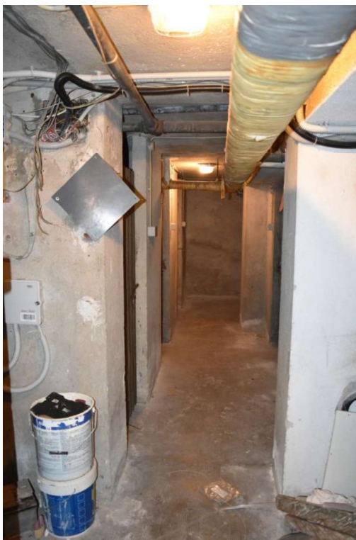
Foto 31: Cantina, vista del disimpegno comune
