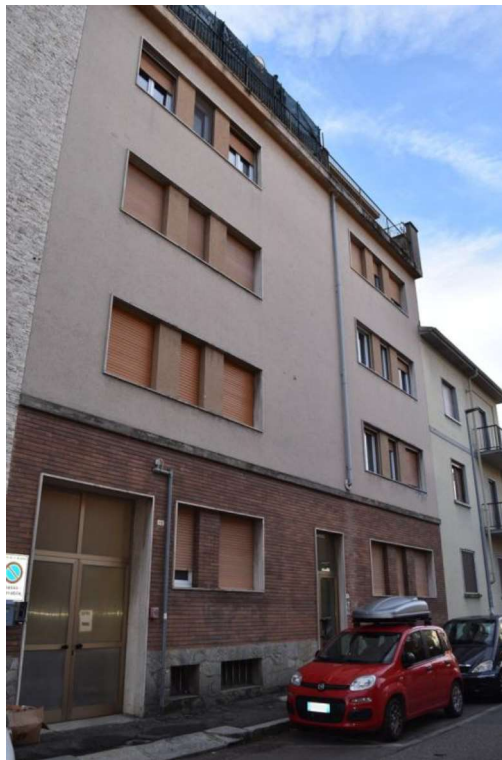
Foto 1: Prospetto su Via Morbio
