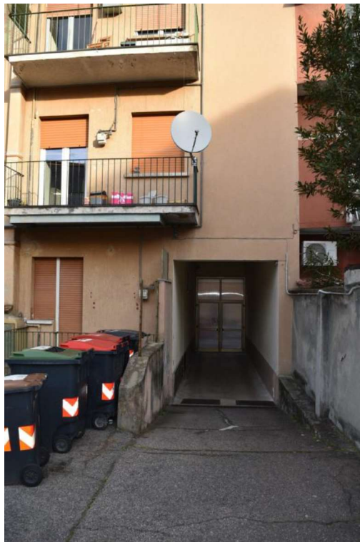
Foto 9: Prospetto su cortile interno, dettaglio accesso carraio
