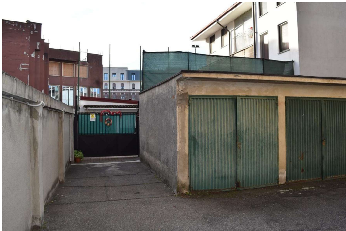
Foto 34: Blocco autorimesse, vista dal cortile interno
