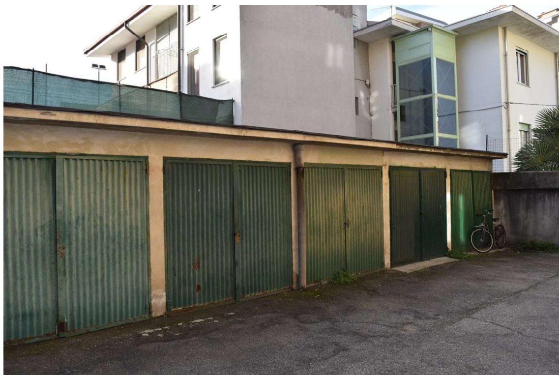
Foto 35: Blocco autorimesse, vista dal cortile interno
