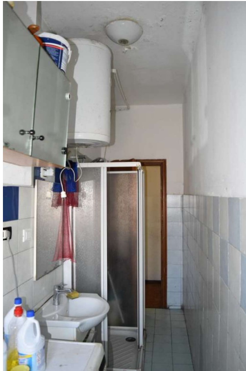
Foto 26: Servizio igienico, vista verso la porta d'ingresso
