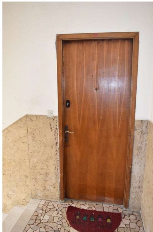
Foto 13: Vano scala condominiale e porta d'accesso appartamento
