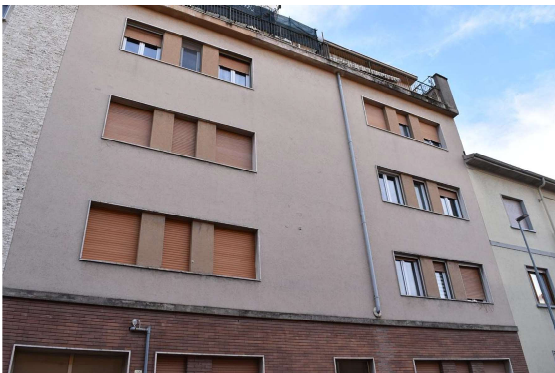
Foto 5: Prospetto su Via Morbio
