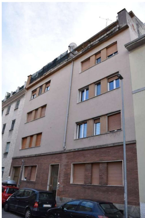
Foto 2: Prospetto su Via Morbio
