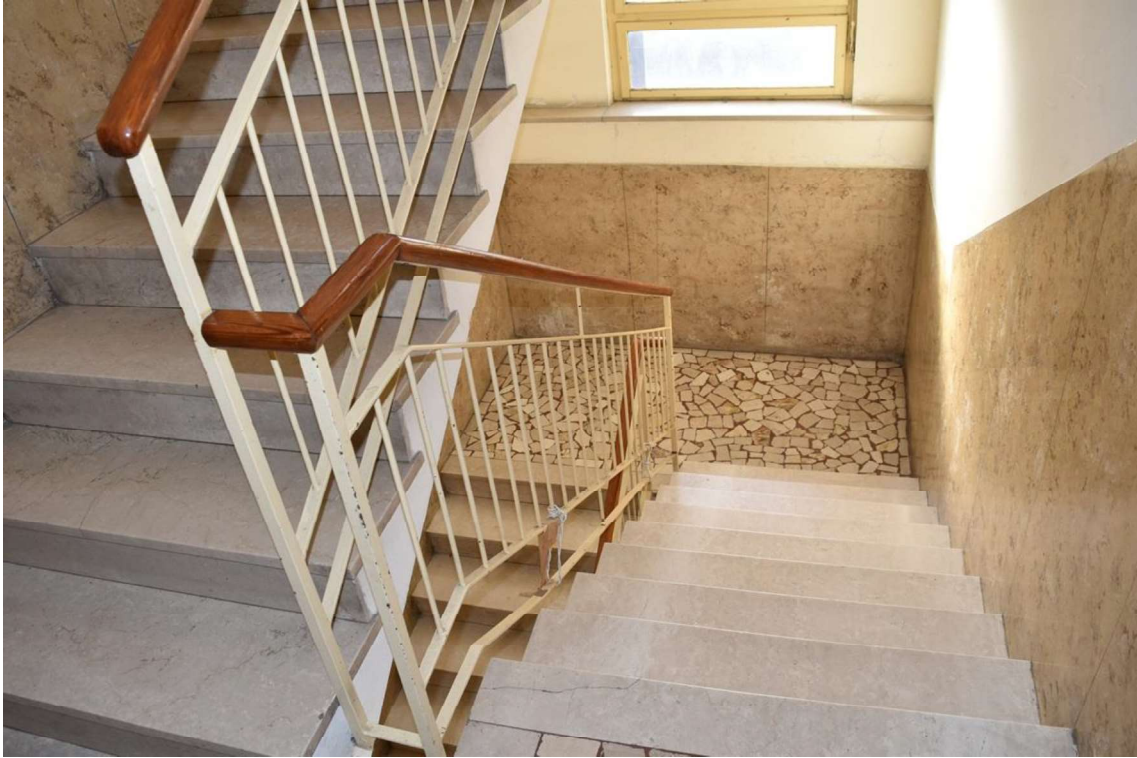
Foto 12: Vano scala condominiale
