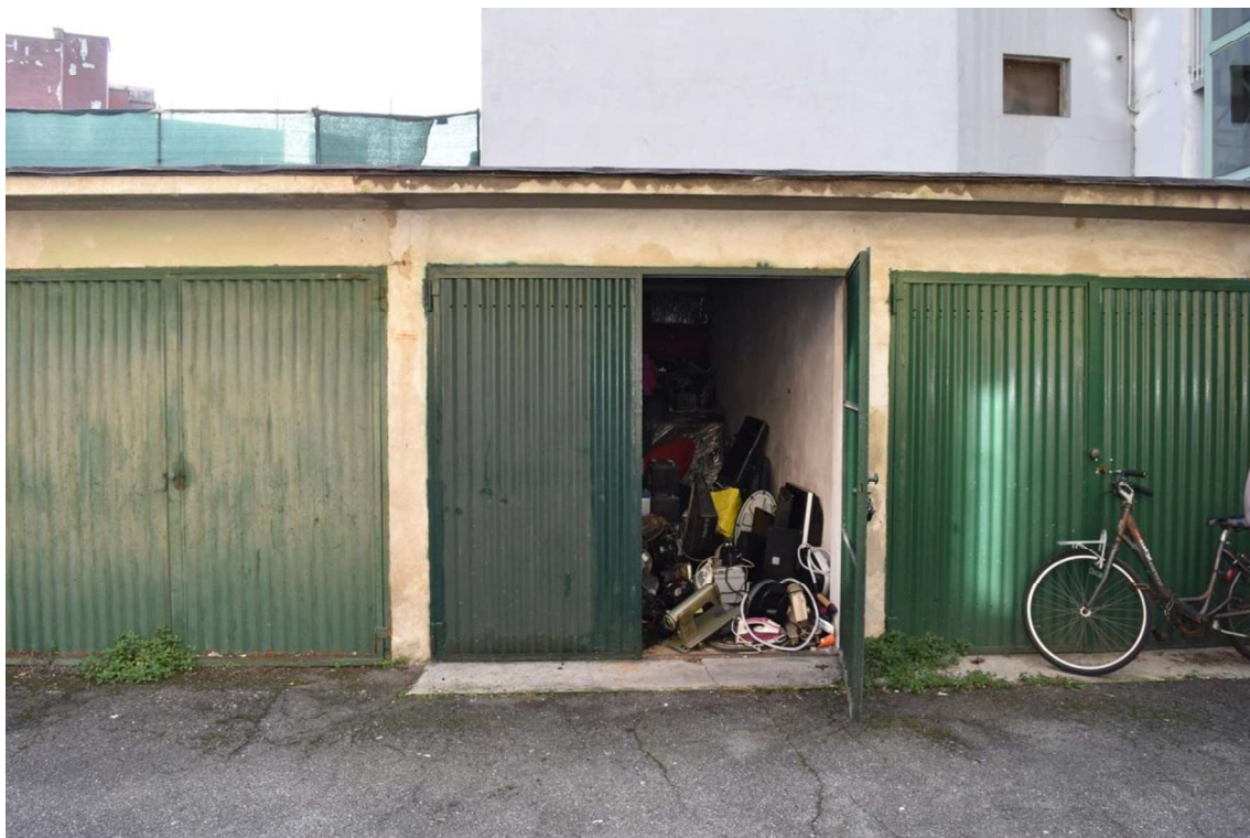
Foto 36: Autorimessa, vista dal cortile interno
