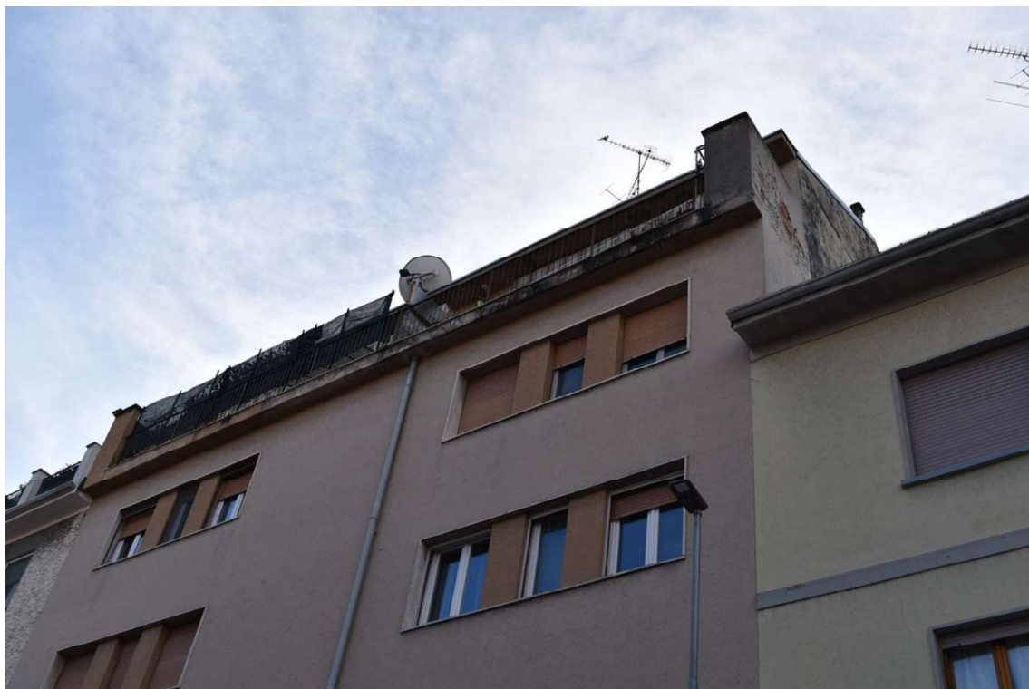
Foto 4: Prospetto su Via Morbio
