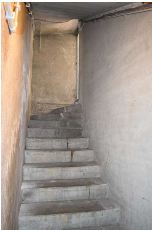
Foto 30: Cantina, vista scala d'accesso
