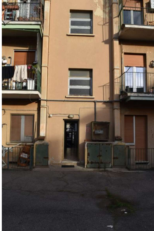
Foto 8: Prospetto su cortile interno, dettaglio accesso pedonale
