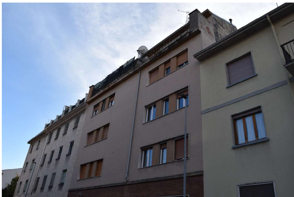
Foto 3: Prospetto su Via Morbio
