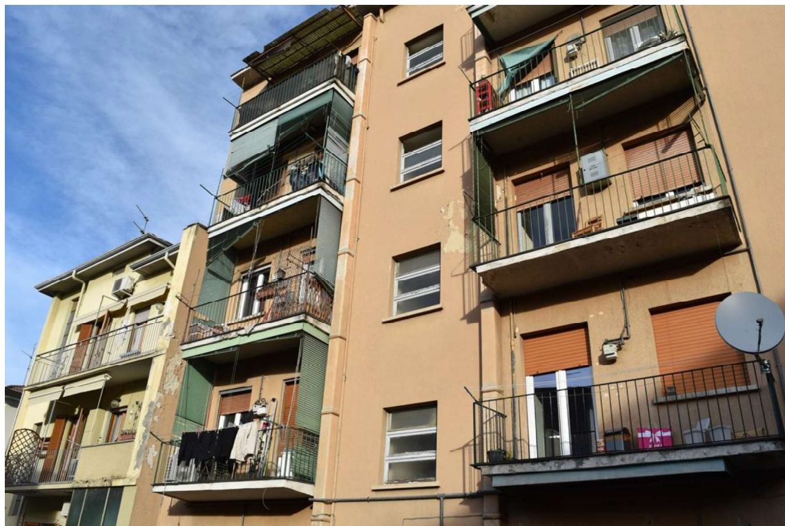
Foto 7: Prospetto su cortile interno
