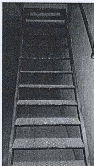
Scala di accesso dal garage alla cantina
