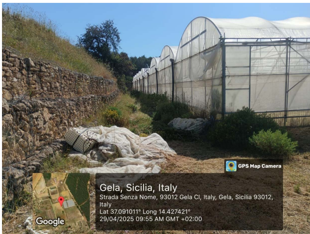
Foto n.13 particolare dei muri di contenimento presenti sulle pareti dei dislivelli adiacente l'impianto serricolo ricadente nella particella 145 del foglio fdi mappa 171
