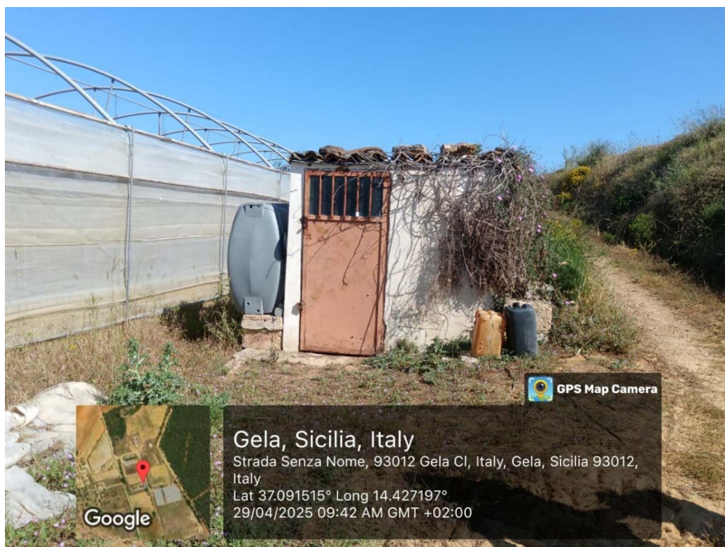
Foto n.11 particolare dell'annesso agricolo serricolo ricadente nella particella 141 del foglio di mappa 171
