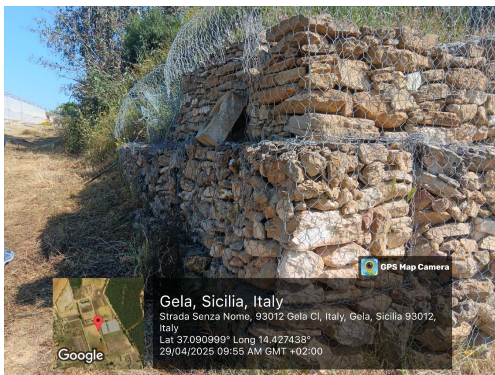
Foto n.12 particolare dei muri di contenimento presenti sulle pareti dei dislivelli adiacenti l'impianti serricoli
