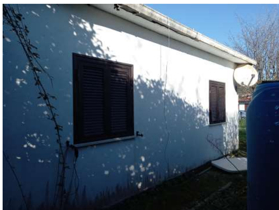
Foto esterna Lato SX abitazione p.lla 1255 sub2
