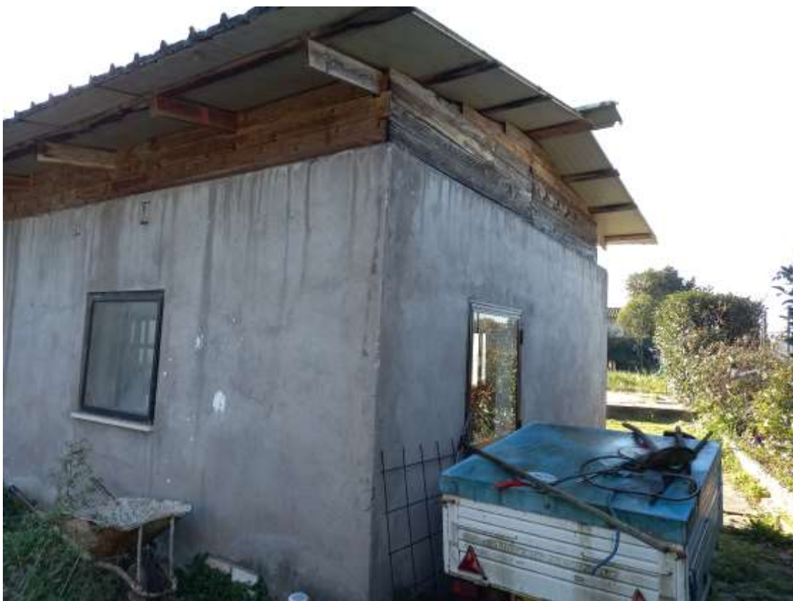
Foto esterna (retro-sx) Monolocale p.lla 1254 sub2
