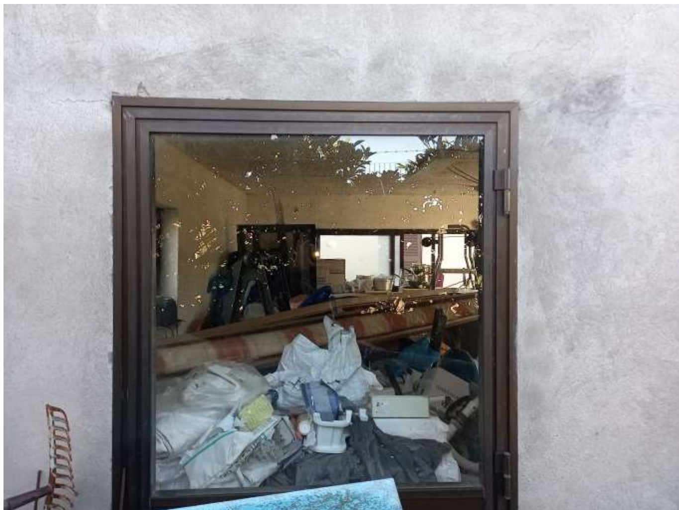
Foto particolare Monocale p.la 1254 sub2
