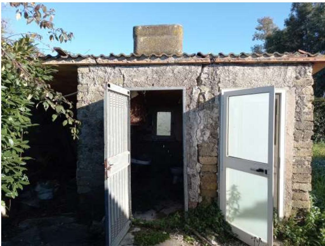
Foto esterna (fronte) Locale svz igienici p.lla 1254 sub2
