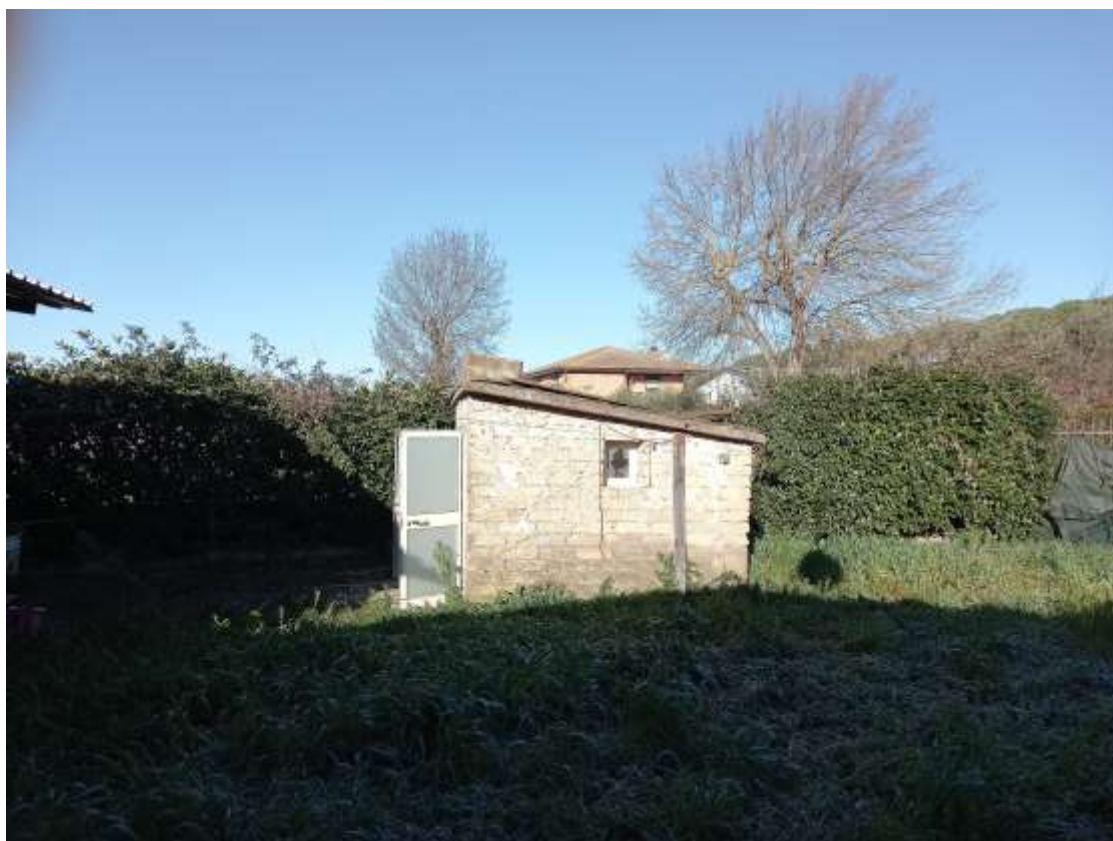
Foto esterna (lato) Locale svz igienici p.lla 1254 sub2
