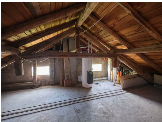
Foto n° 23: Piano terzo, soffitta
