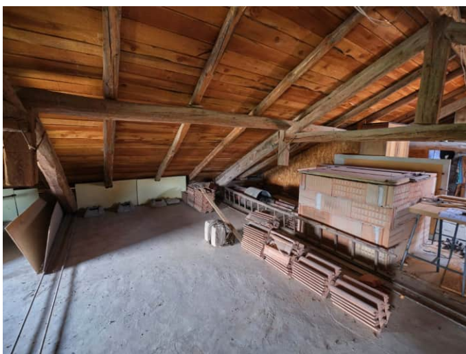
Foto n° 24: Piano terzo, soffitta
