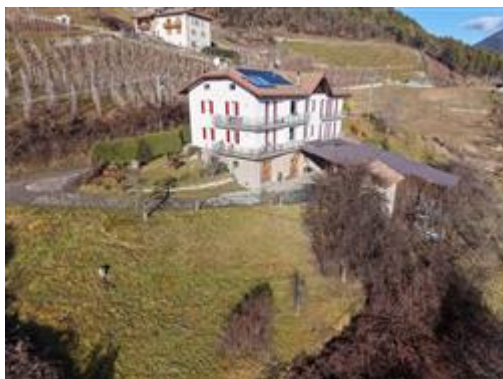
Foto n° 1: Vista generale fronti sud e est
