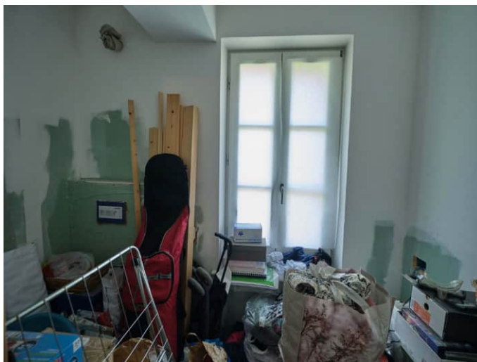
Foto n° 20: Piano primo, w.c. nord
