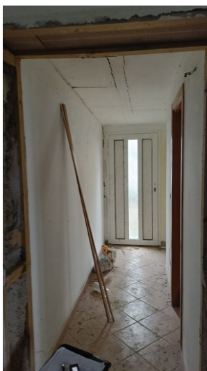
Corridoio corpo di fabbrica da demolire
