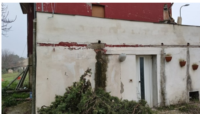
Corpo di fabbrica da demolire lato sx
