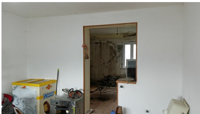
PT – locali lato sx corridoio ingresso
