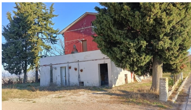
Lato Sx con evidenza del corpo di fabbrica da demolire
