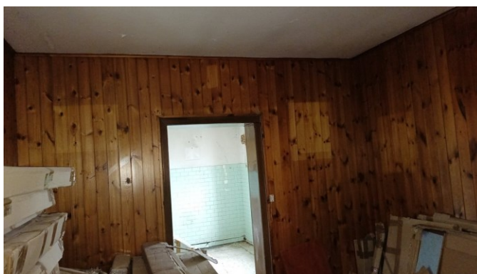
PT – locali lato dx corridoio ingresso
