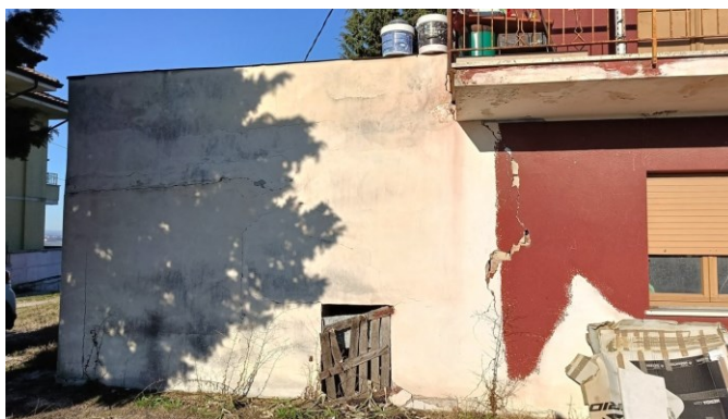
Corpo di fabbrica da demolire – vista dalla strada
