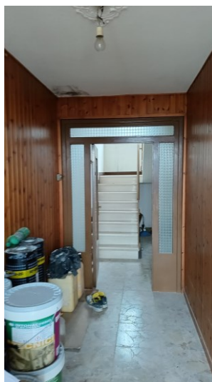
PT corridoio ingresso
