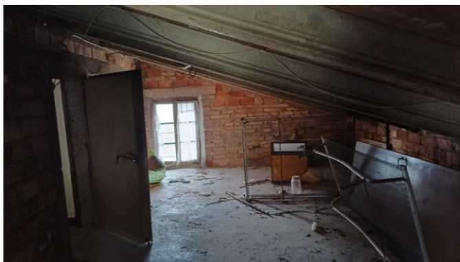
Soffitta con ingresso dal vano scala
