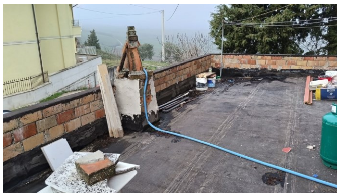
Solaio copertura manufatto da demolire utilizzato a terrazzo
