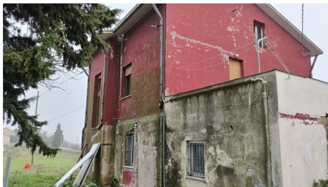
Retro fabbricato e lato sx con evidenza del manufatto da demolire
