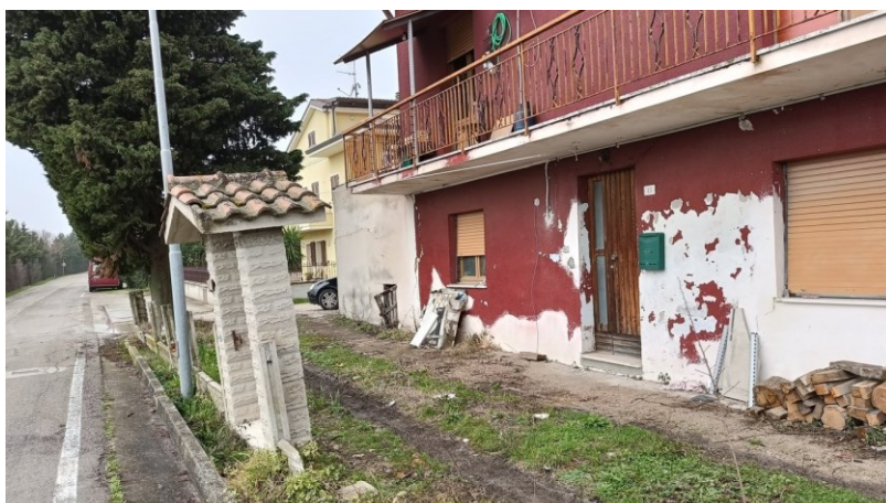
Muro recinzione e pensilina lato strada pericolanti
