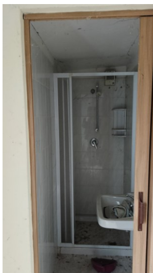
Locale doccia corpo di fabbrica da demolire
