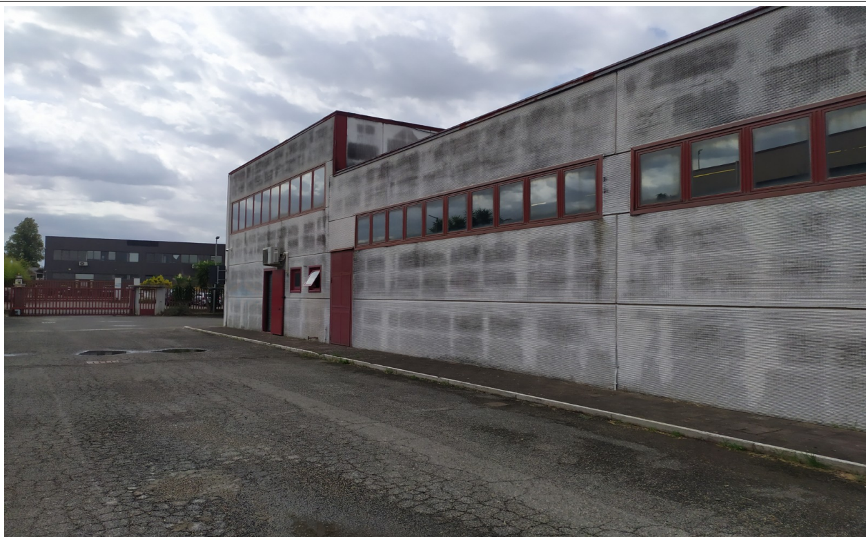
Foto n.4. Vista del lato destro del fabbricato verso l’ingresso su Via Catania. Si evidenzia il corpo destinato agli uffici su due livelli e parte del edificio destinato alla produzione dei cosmetici ad un solo livello
