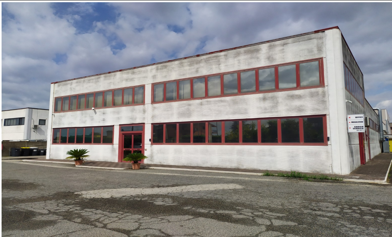
Foto n.3. Vista del primo fabbricato industriale (Corpo “A”) edificato con Concessione Edilizia n.5/1988. La foto mostra l’ingresso agli uffici amministrativi, sale incontri promozionali e informativi.
