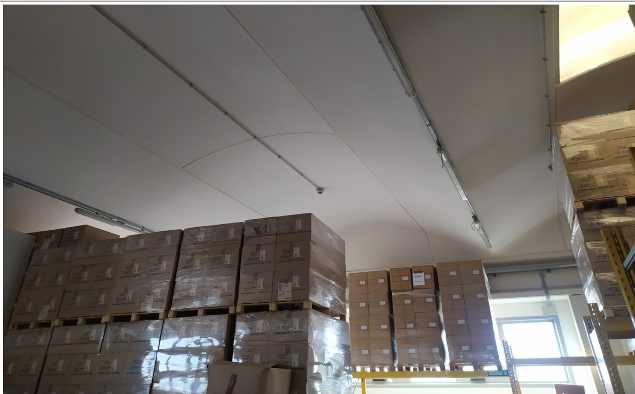
Foto n.8. Vista interna del magazzino e deposito materie prime e prodotti finiti del secondo fabbricato industriale (Corpo “B”) edificato con Concessione Edilizia n.115/2007-C.
