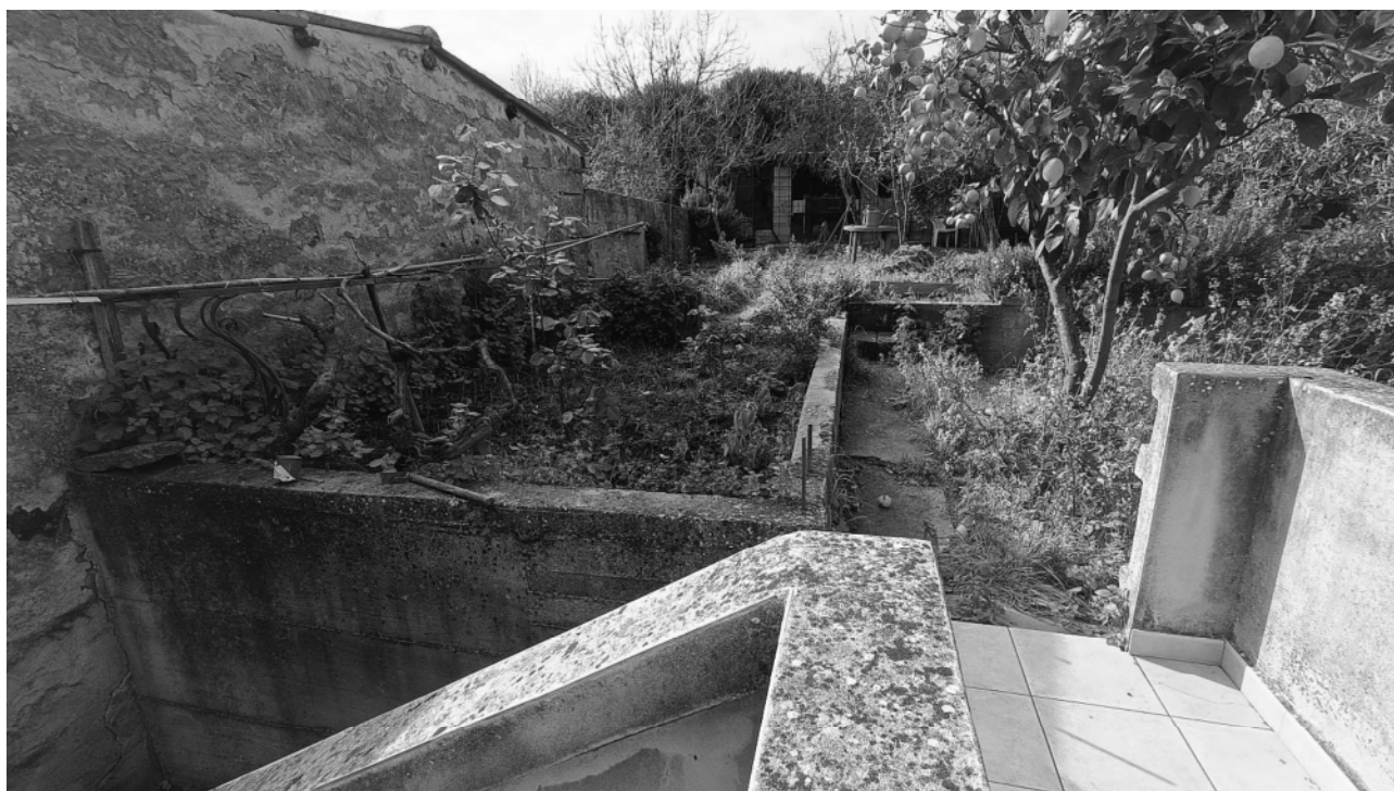
Foto 46 – lato retrostante del lotto – vista ballatoio sospeso accesso piano secondo/cortile sopraelevato (18)
