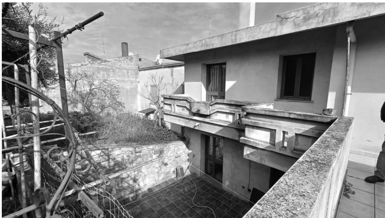
Foto 45 – lato retrostante del lotto – vista ballatoio sospeso accesso piano secondo/cortile sopraelevato (18)
