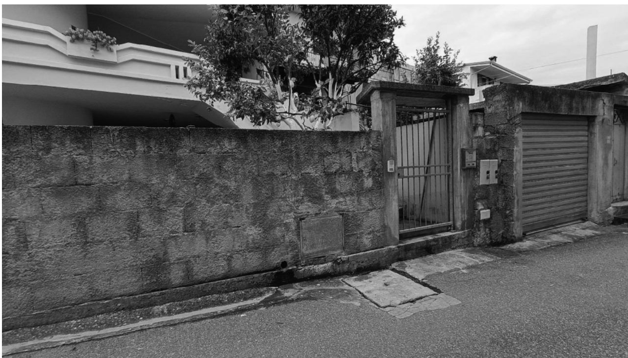
Foto 7 – vista ingresso pedonale su cortile antistante l'immobile – via Generale Sanna n.25
