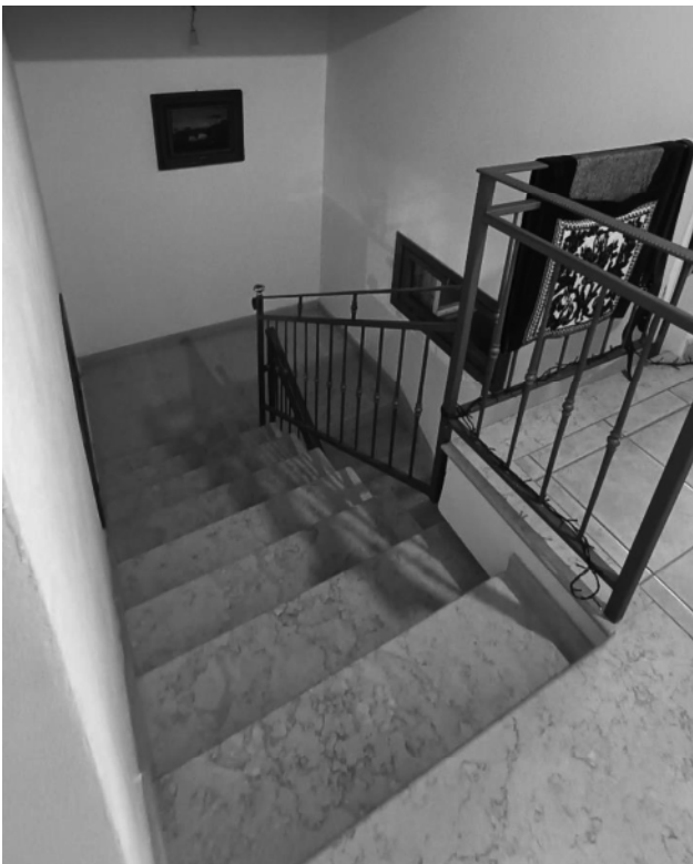
Foto 29 – vano scala interno da piano secondo a piano primo
