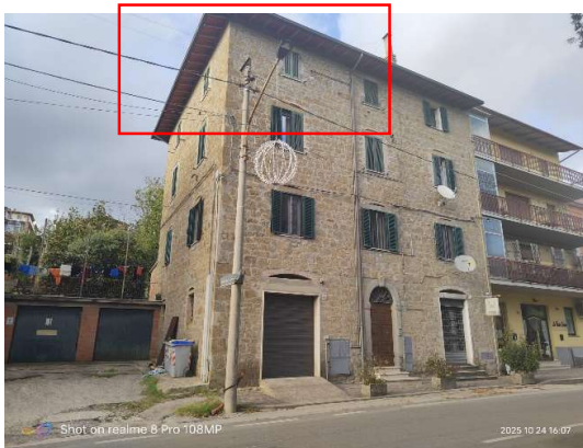
Foto 1: Prospetto lungo via Maniconi
