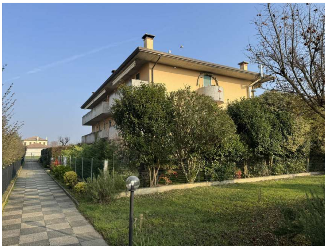
1 - Vista del condominio
