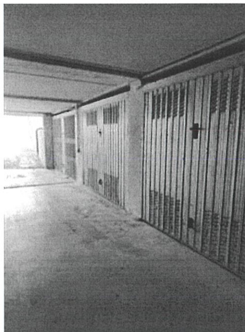
corsia di manovra
