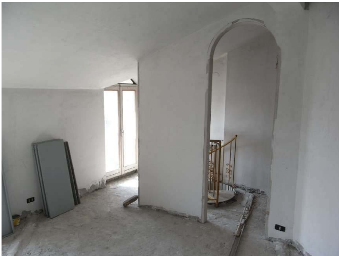
Locale di sgombero
