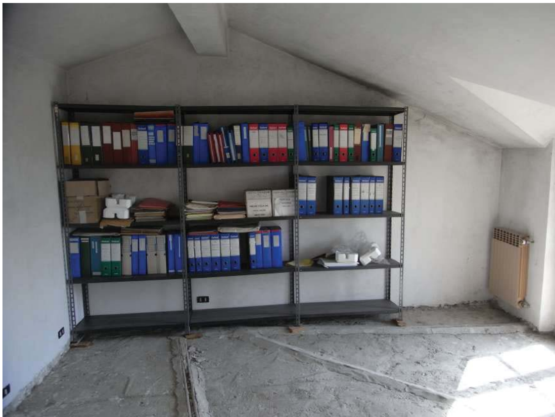
Locale di sgombero
