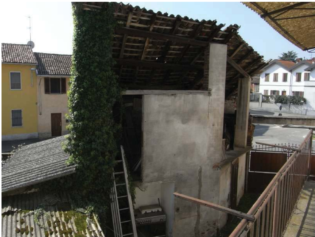
Prospetto lato cortile
