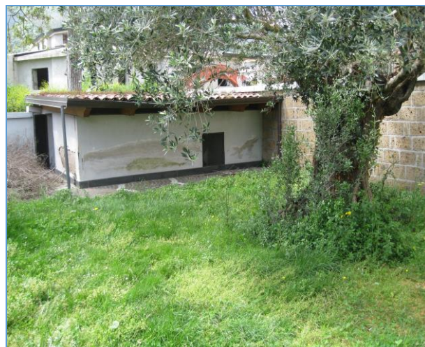
- Locale tecnico presente nella Corte 4 -
