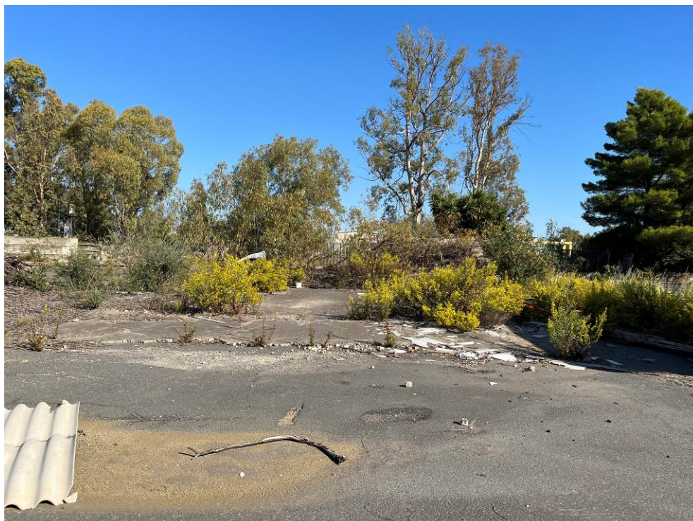
Figura – Area esterna al fabbricato
