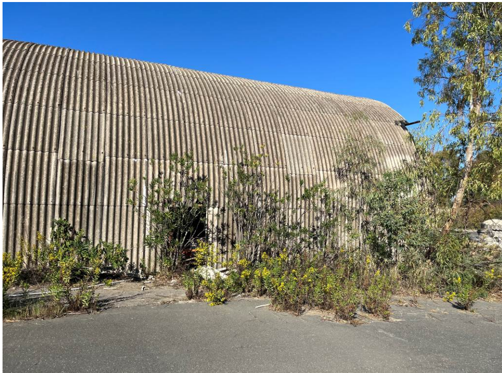
Figura – Capannone – Vista laterale
