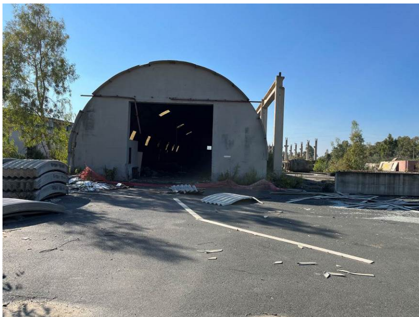
Figura – Capannone – Ingresso principale
