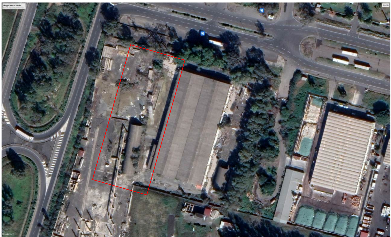
Figura 4 – Inquadramento Satellitare degli immobili di proprietà
