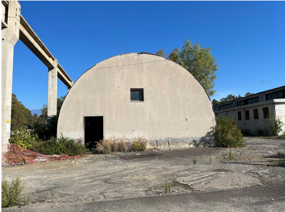
Figura – Capannone – Ingresso posteriore
