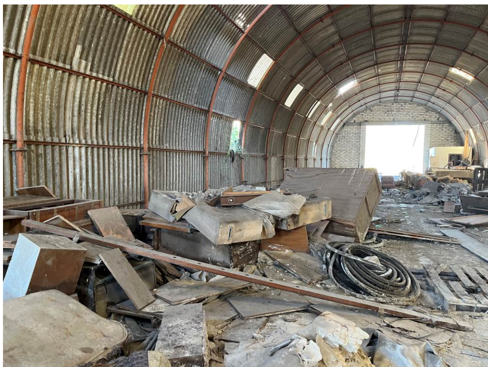
Figura – Capannone – Vista interna
