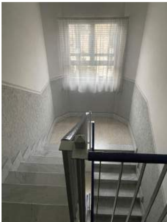
Scala comune di accesso alle unità immobiliari
