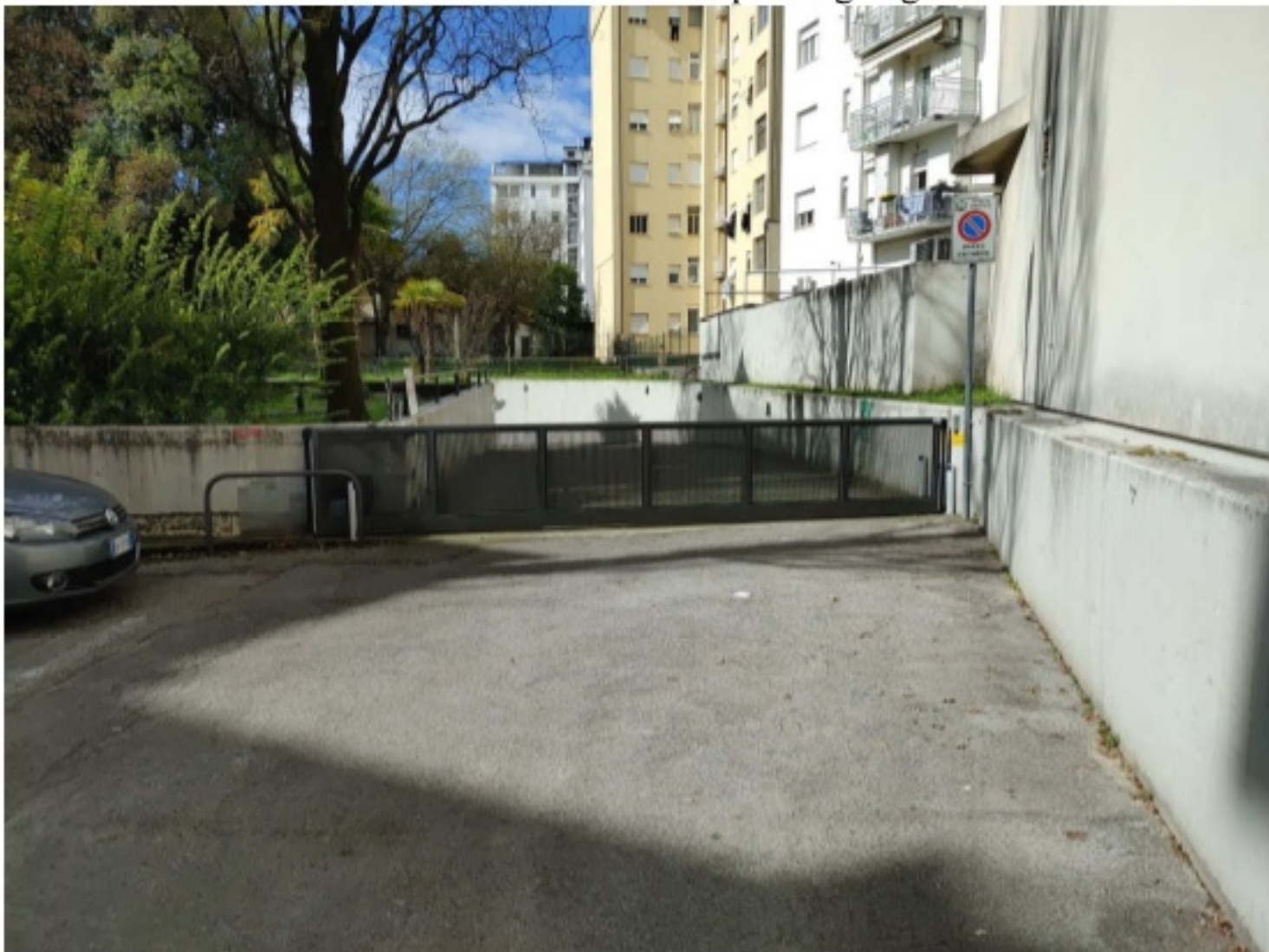
Foto 2 – accesso alla rampa dei garage
