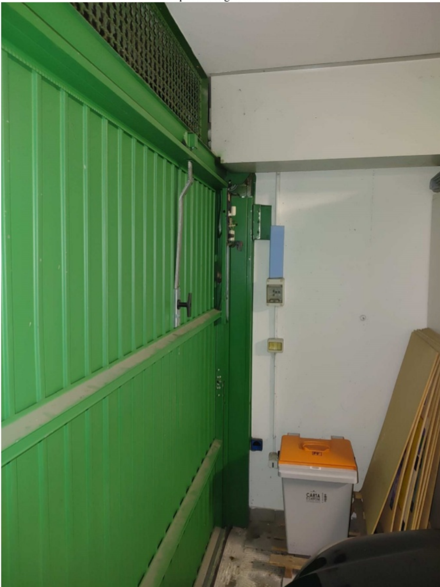
Foto 6 - Vista portone ingresso non motorizzato
