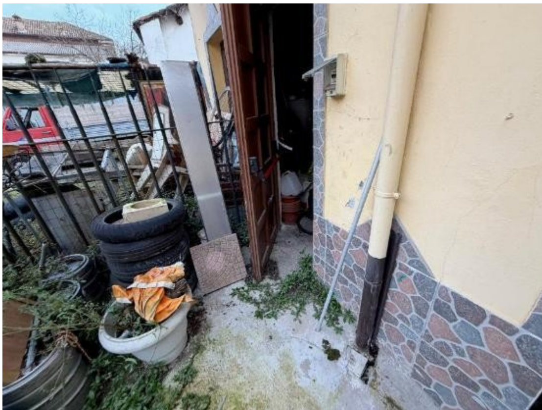
Accesso a Centrale Termica
