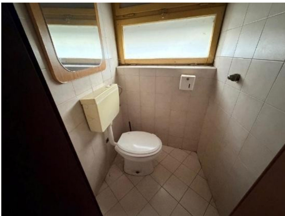
Particolare sanitari Secondo locale bagno
