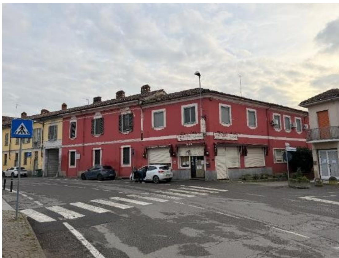
Inquadramento Generale Corpo di Fabbrica – Vista Esterna da Via Cavour
