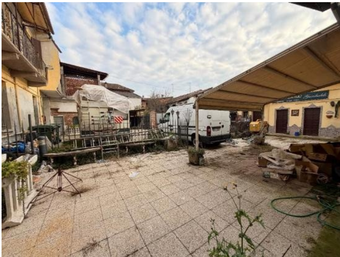
Vista Esterna cortiletto interno
