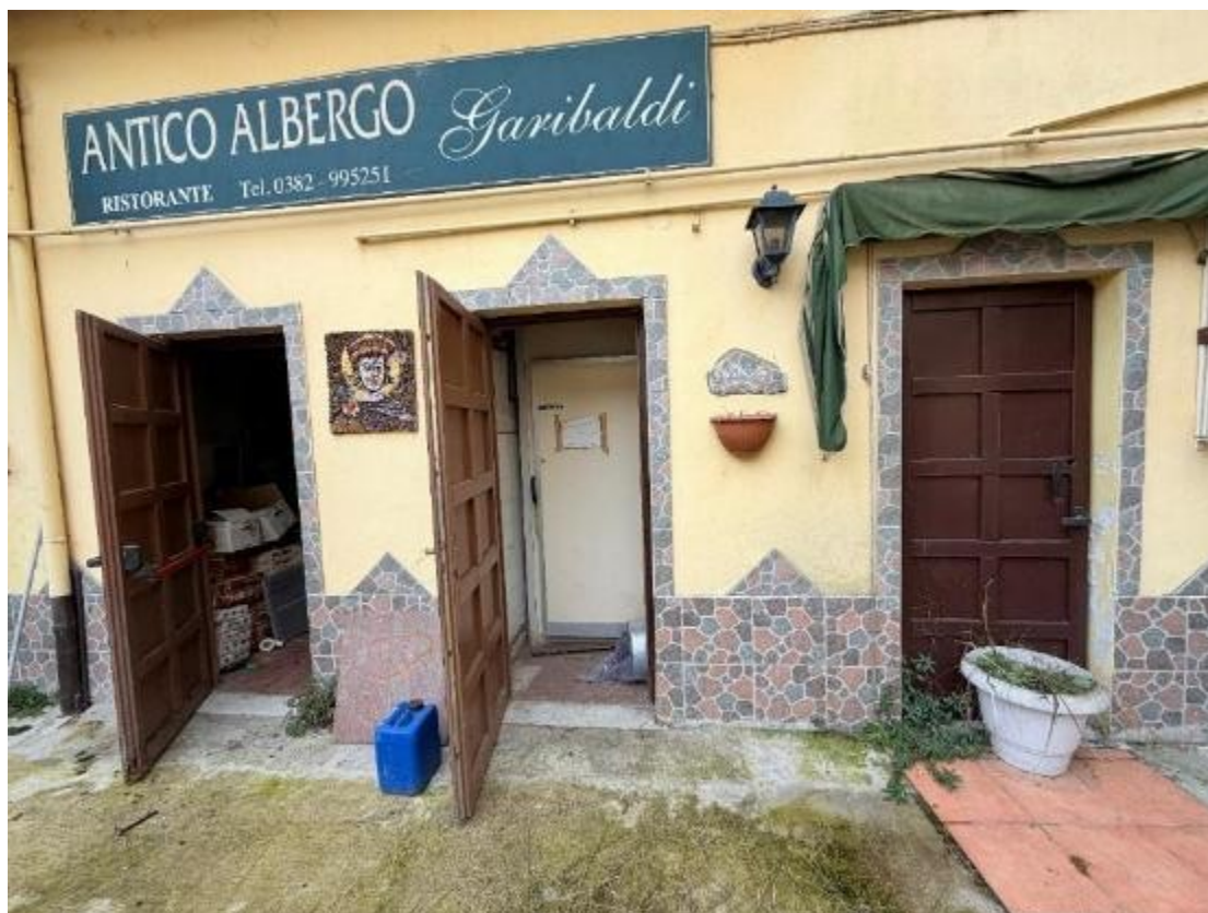
Vista Esterna cortiletto interno – accesso ai vani tecnici
