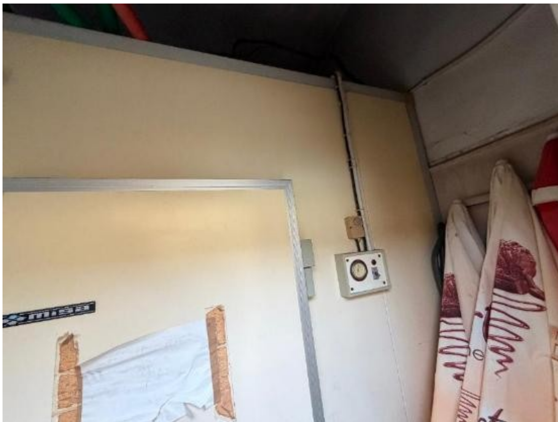
Particolare della Cella Frigo in disuso
