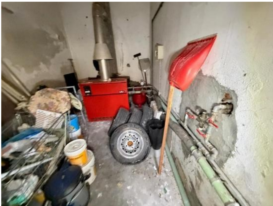
Centrale Termica in disuso
