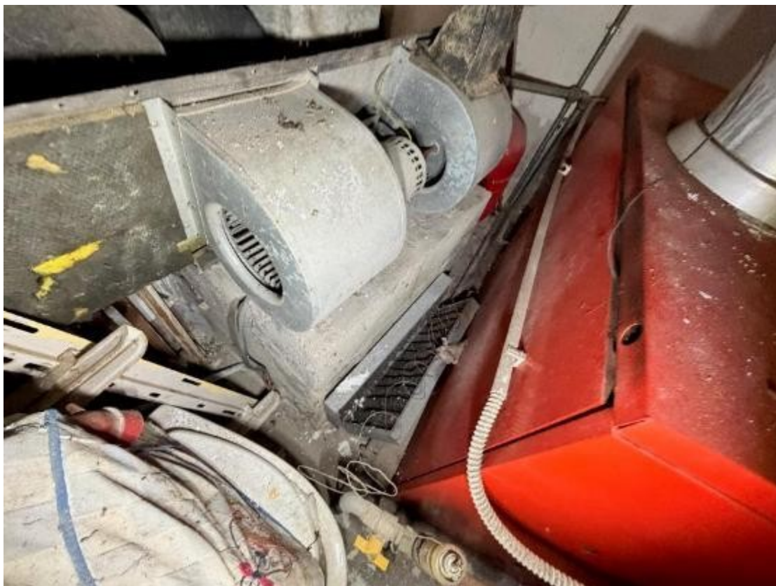
Centrale Termica in disuso
