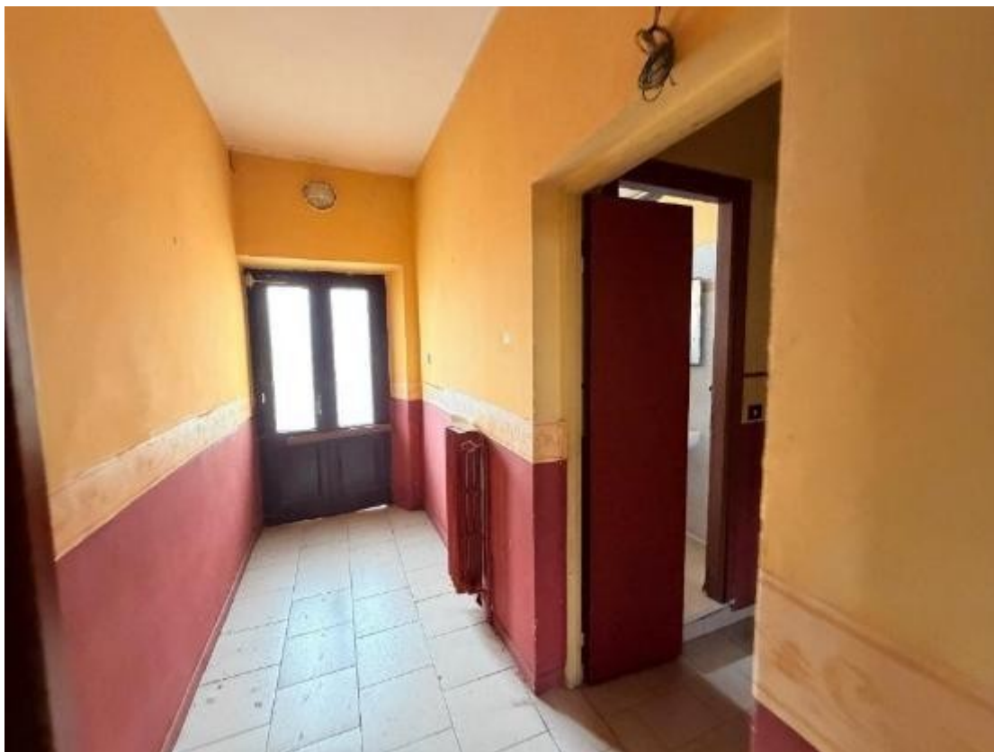
Disimpegno tra camera 113 e 114
