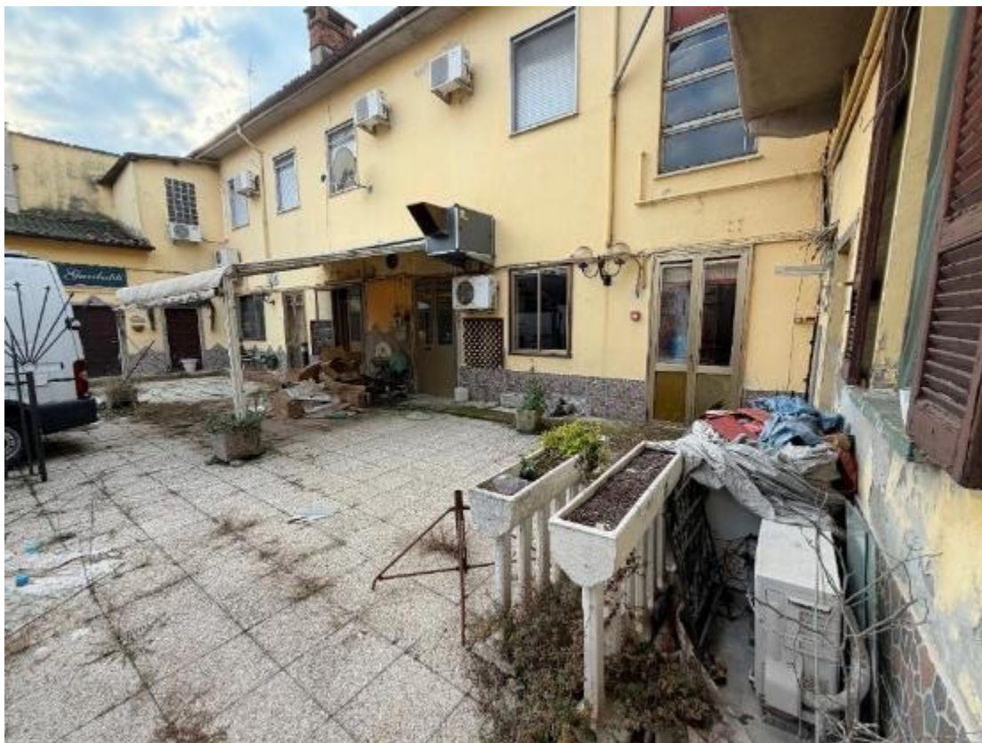
Vista Esterna cortiletto interno
