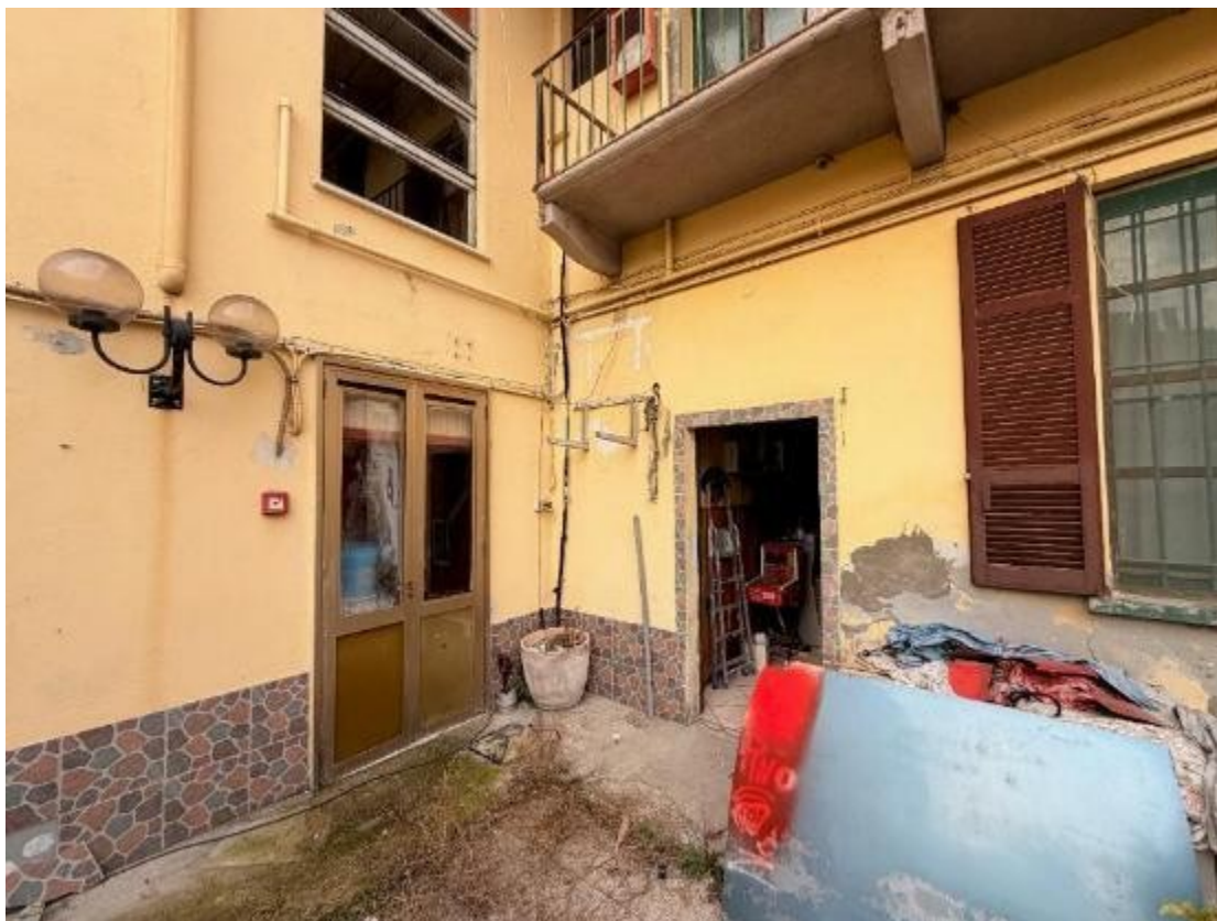
Vista Esterna cortiletto interno
