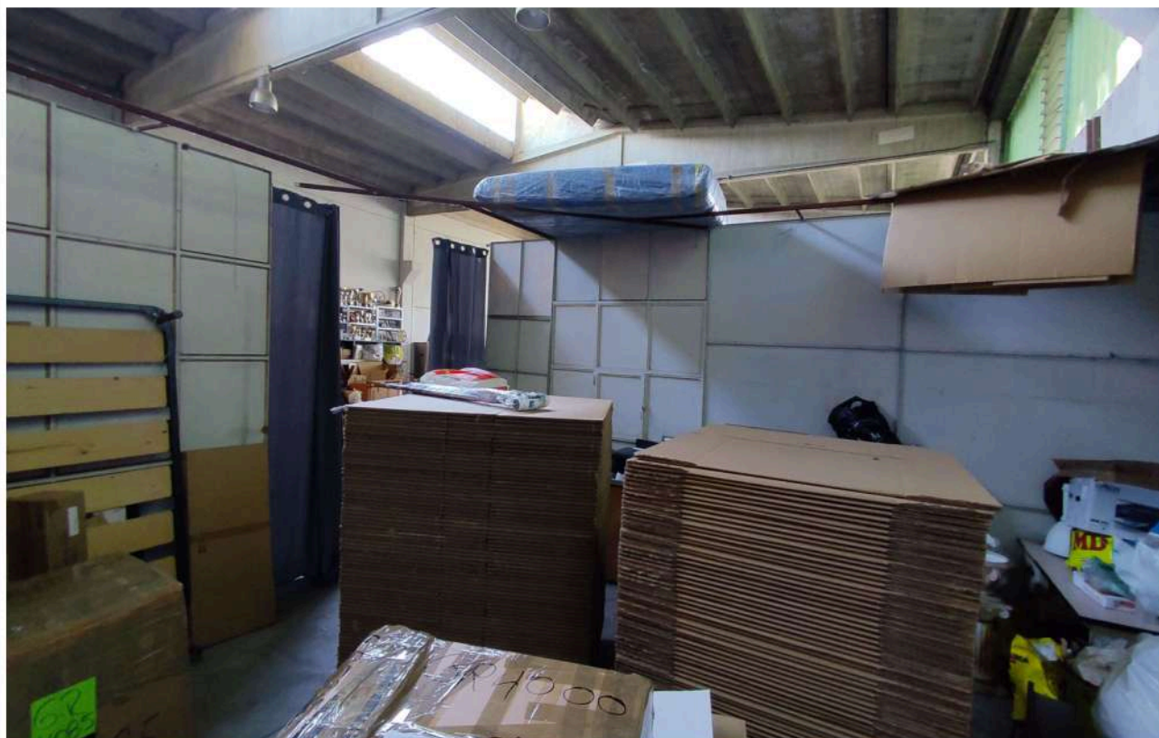
Locale deposito materiali
