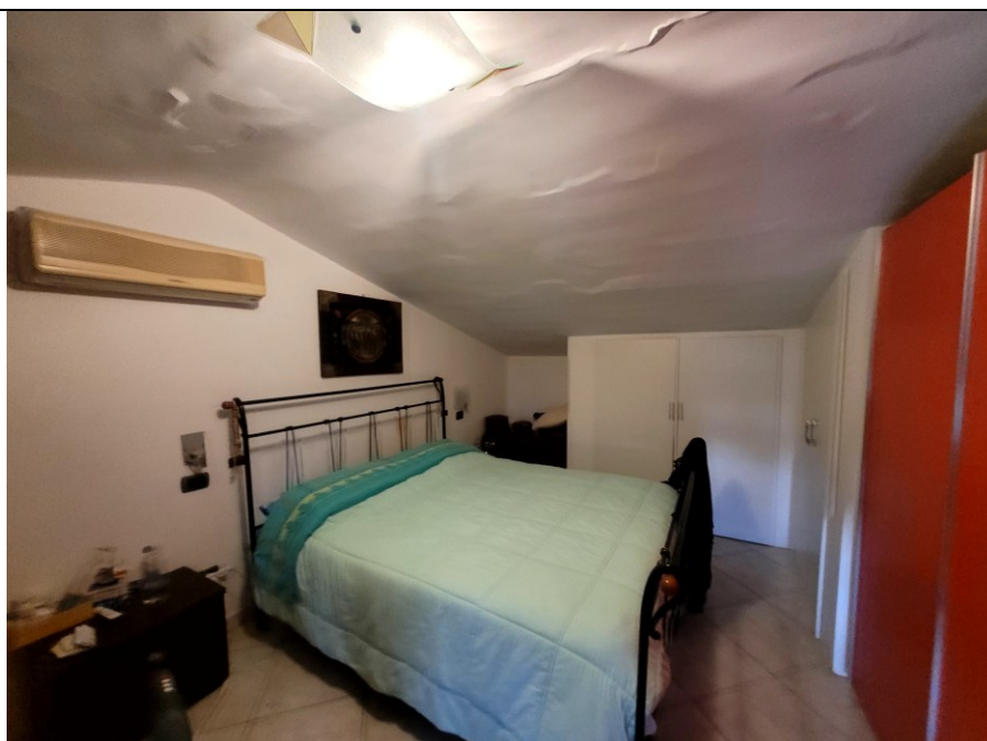
Foto 6 Piano sottotetto: primo ambiente letto
