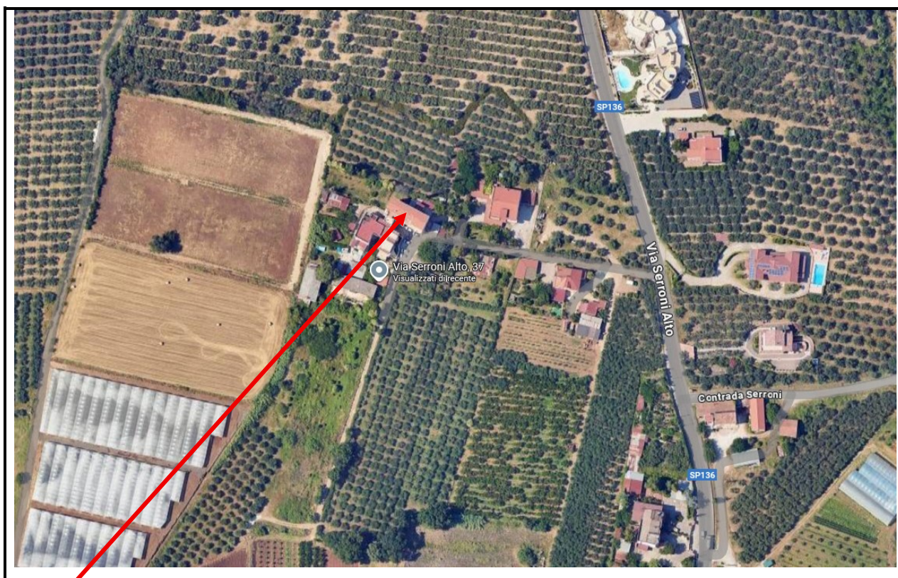
Foto 1 – Edificio sito nel Comune di Battipaglia (Sa) alla Via Serroni alto civ. 37 – già SP 136 (immagine tratta da Google Earth)
