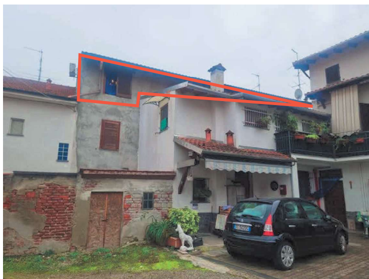
Foto 2 – Vista esterna – Prospetto nord
