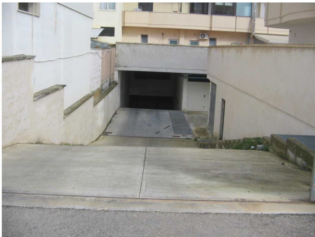
Scivolo di accesso ai piani interrati 1 e 2 - via da denominare
