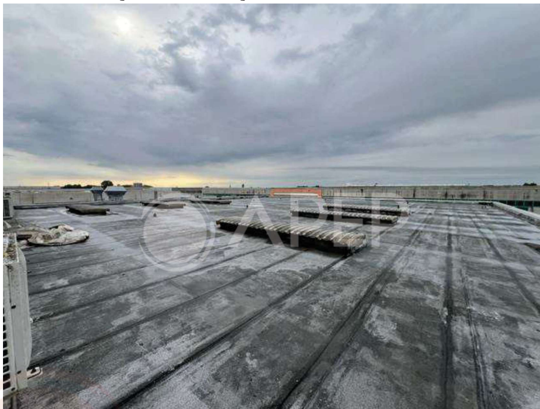
Panoramica sulla copertura da sud ovest
