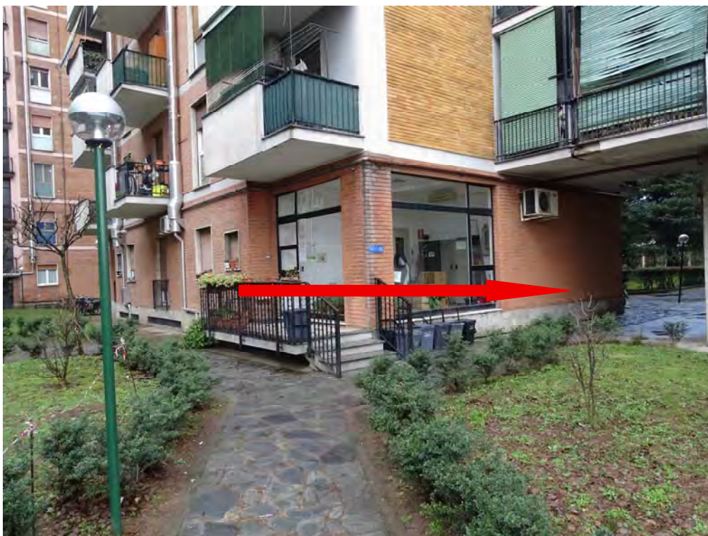
Vista portineria e accesso e passaggio
