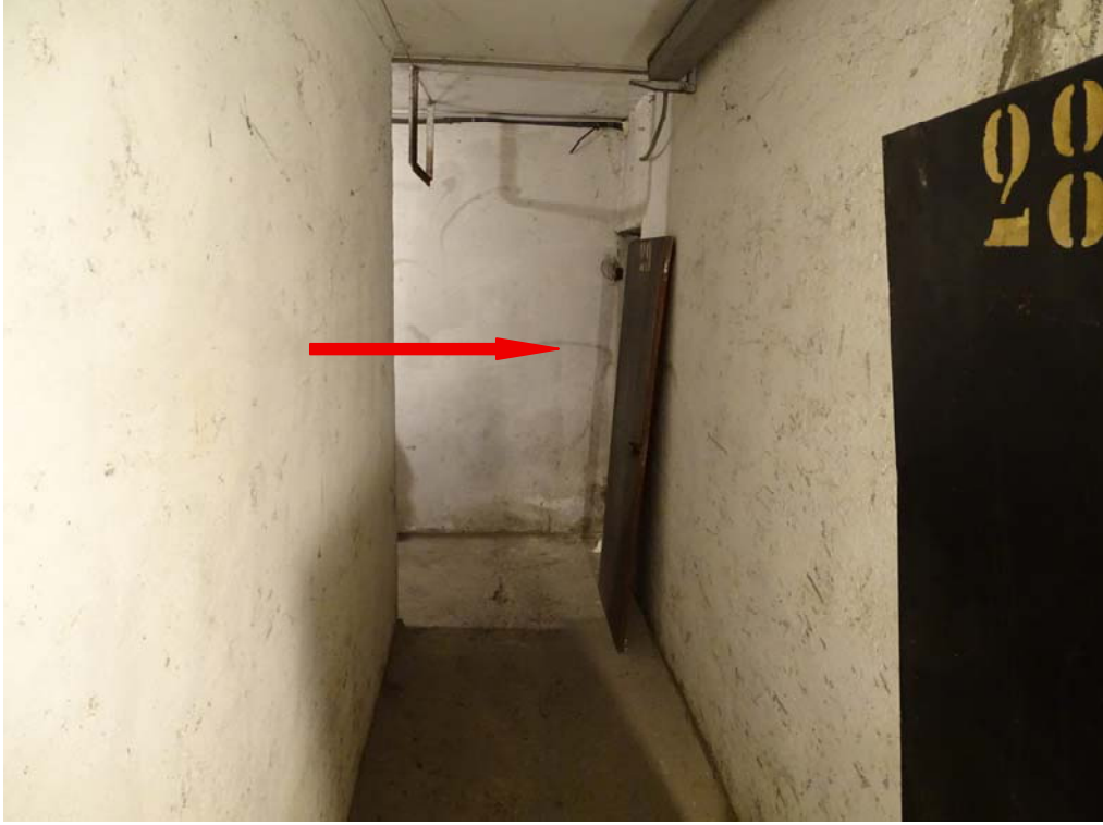
Vista cantina da corridoio laterale
