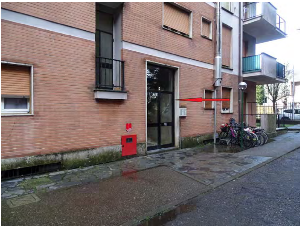
Vista ingresso condominio (scala D)
