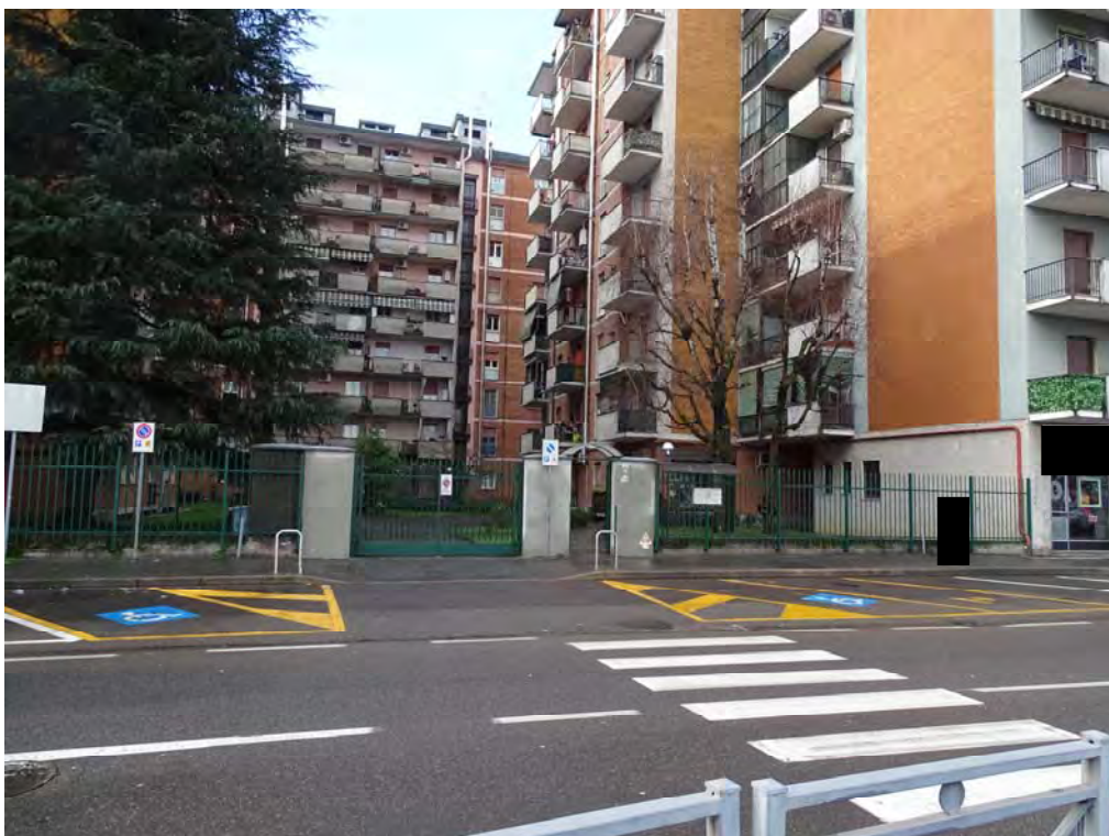
Vista da via Turati ingresso al complesso immobiliare
