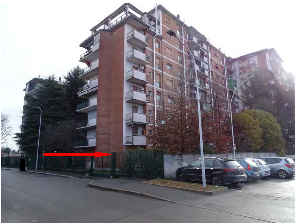
Vista fabbricato da via Saffi
