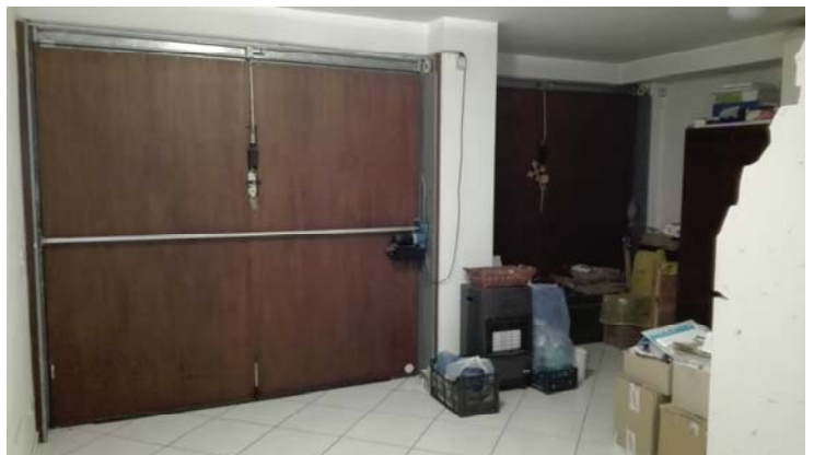
Fig. 10 - vista interna autorimessa
