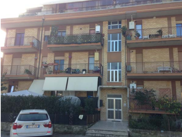
Fig. 15 - vista lato nord-est- ingresso palazzina
