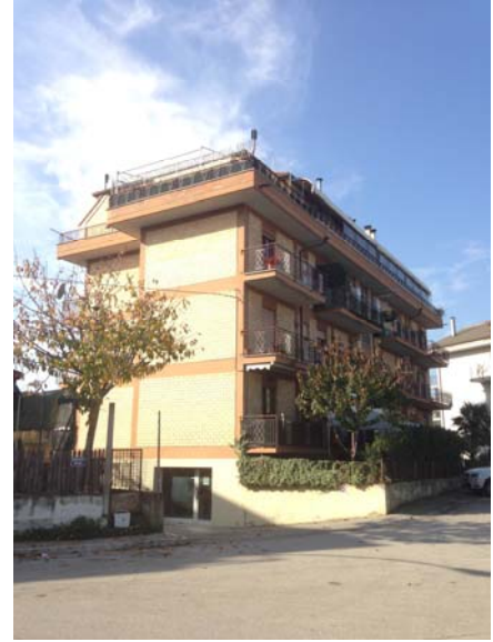
Fig. 16 - vista lato sud-est
