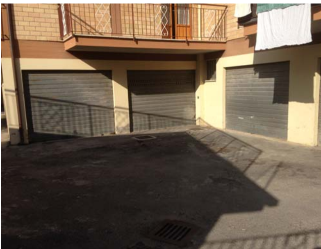
Fig. 17 - vista ingresso esterno
