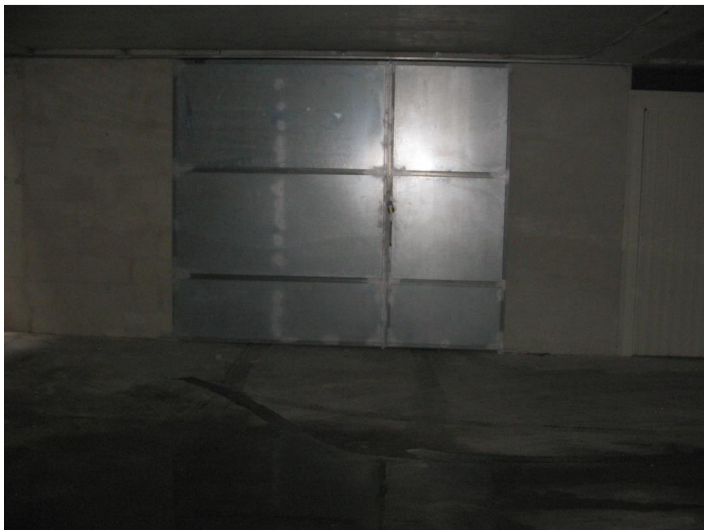
Portone d'accesso al box sub. 66 – piano interrato 2
