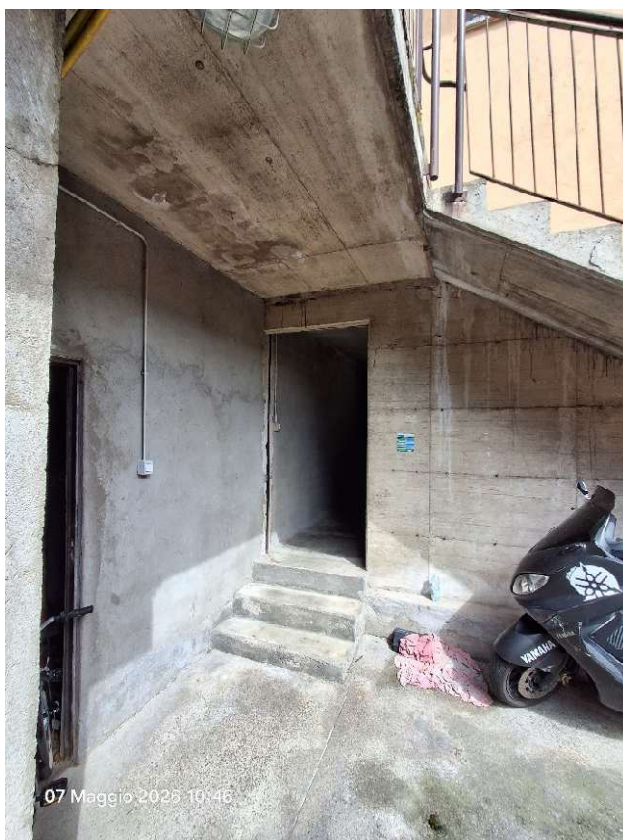
FOTO 10 - Vista esterna accesso piano interrato
