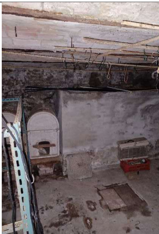
Immagine 32 – Cantina interrata
