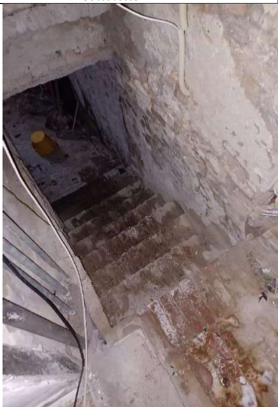
Immagine 31 – Rampa interna tra piano terra e piano interrato
