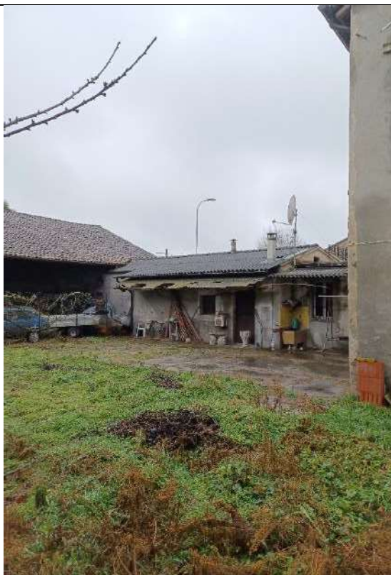
Immagine 9 - Blocco accessorio esterno adiacente all'abitazione
