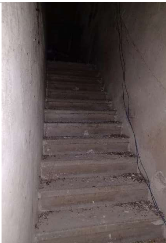
Immagine 29 – Rampa interna tra piano primo e sottotetto
