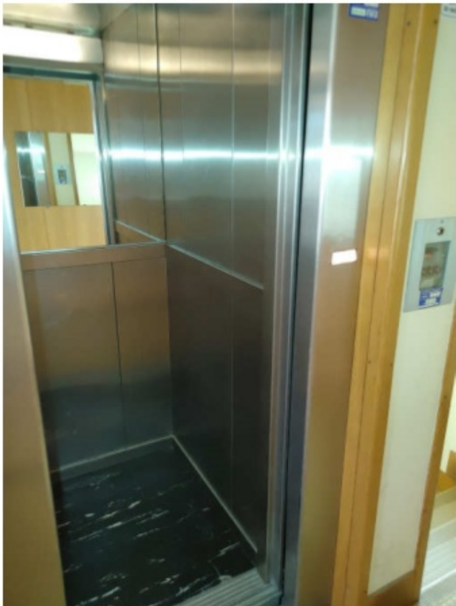
Foto 8 – Vista ascensore condominiale
