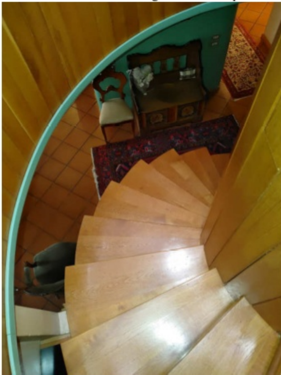
Foto 32 – Scala di collegamento al 5° piano
