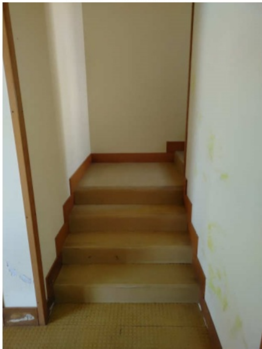
Foto 9 – Vista vano scale
