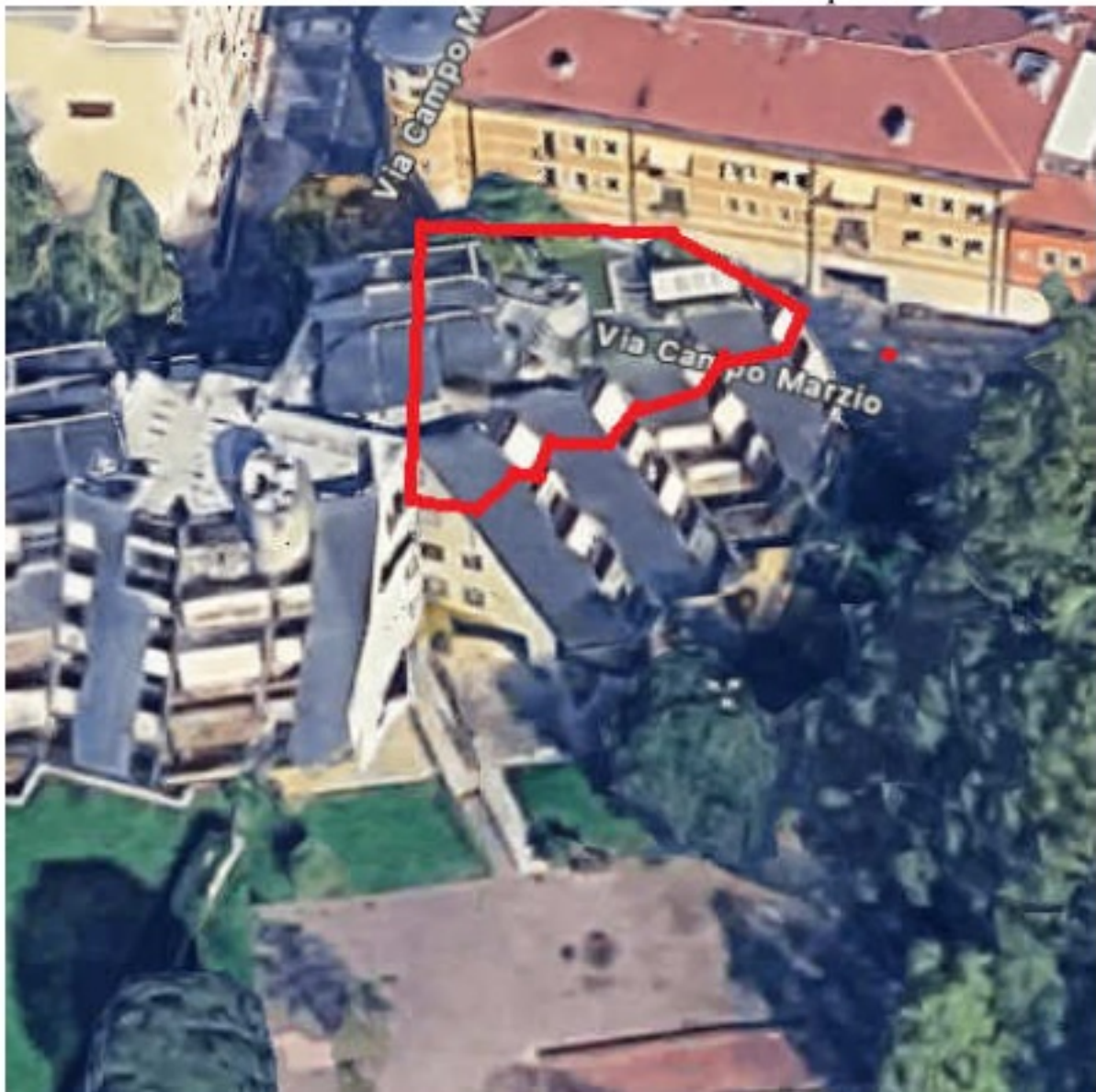
Foto 2 – Perimetrazione unità - 4° e 5° piano
