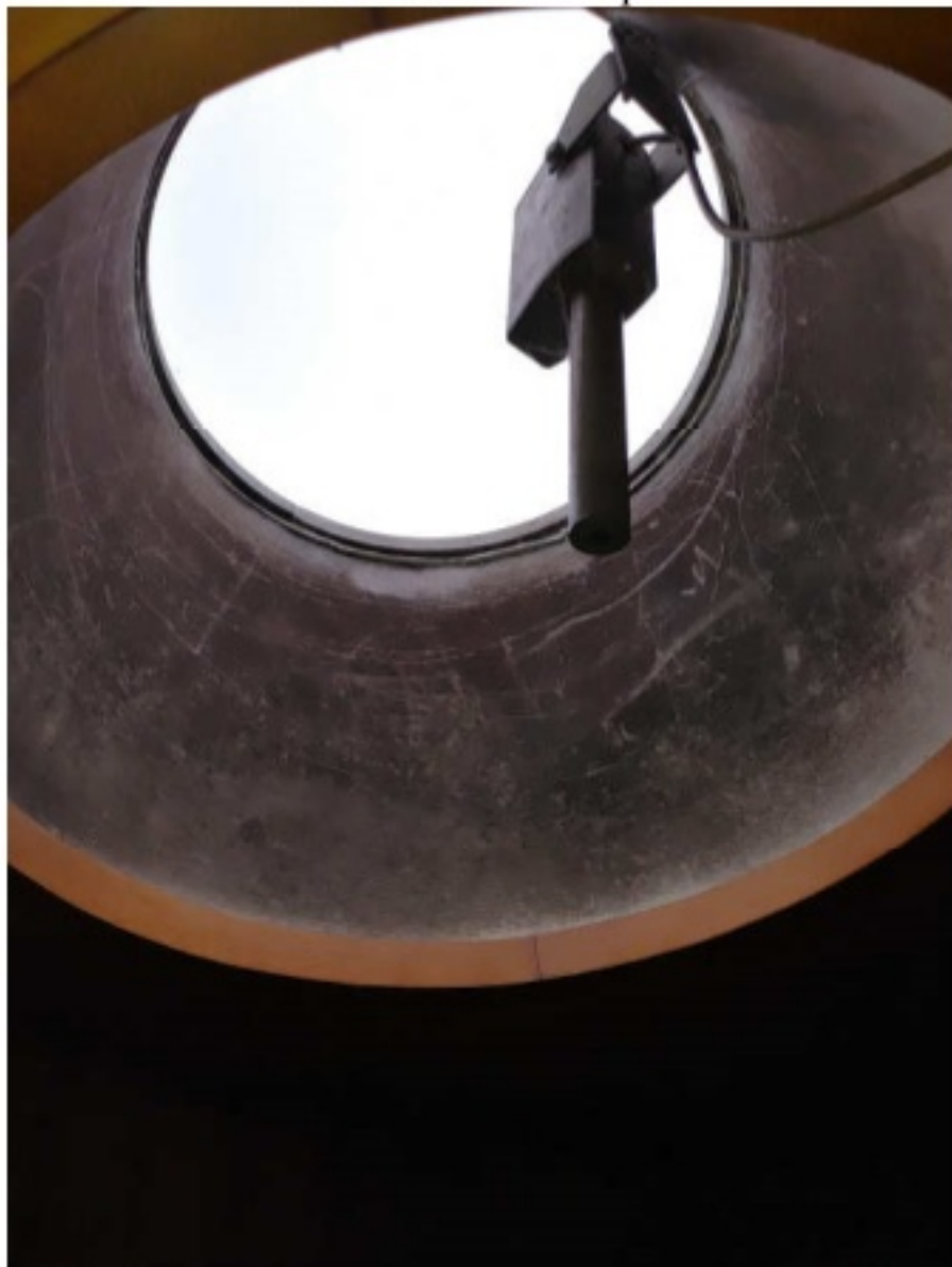
Infiltrazioni d'acqua
