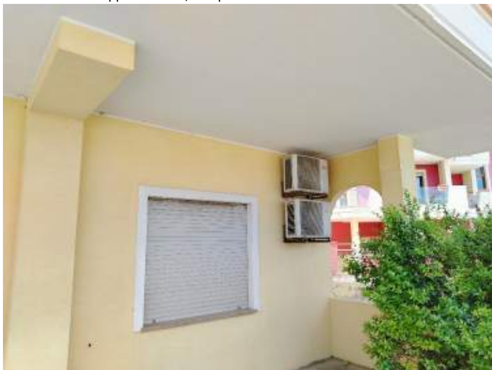
Foto 12) Parete esterna dell'appartamento, lato piazzale interno al fabbricato.
