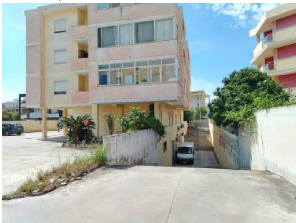
Foto 13) Rampa carrabile che dal civ. 1 della via Italia serve piano interrato e piazzale interno al fabbricato dove trovano i posti auto scoperti.
