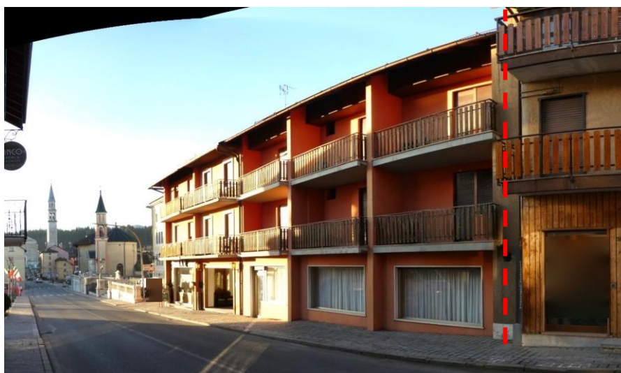
3. – Albergo / Ristorante – lato Sud/Est fronte Via Roma
