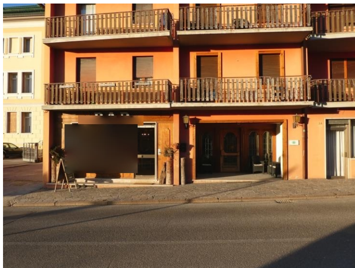
12. – Accessi al Bar ed all’Albergo / Ristorante – lato Sud fronte Via Roma
