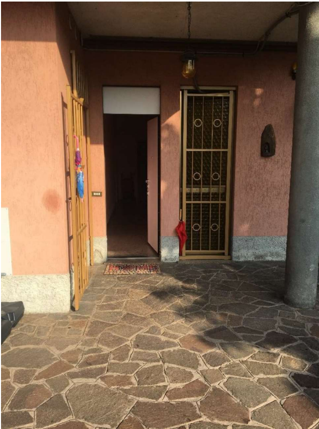
INGRESSO VANO SCALA da PIANO SEMINTERRATO
