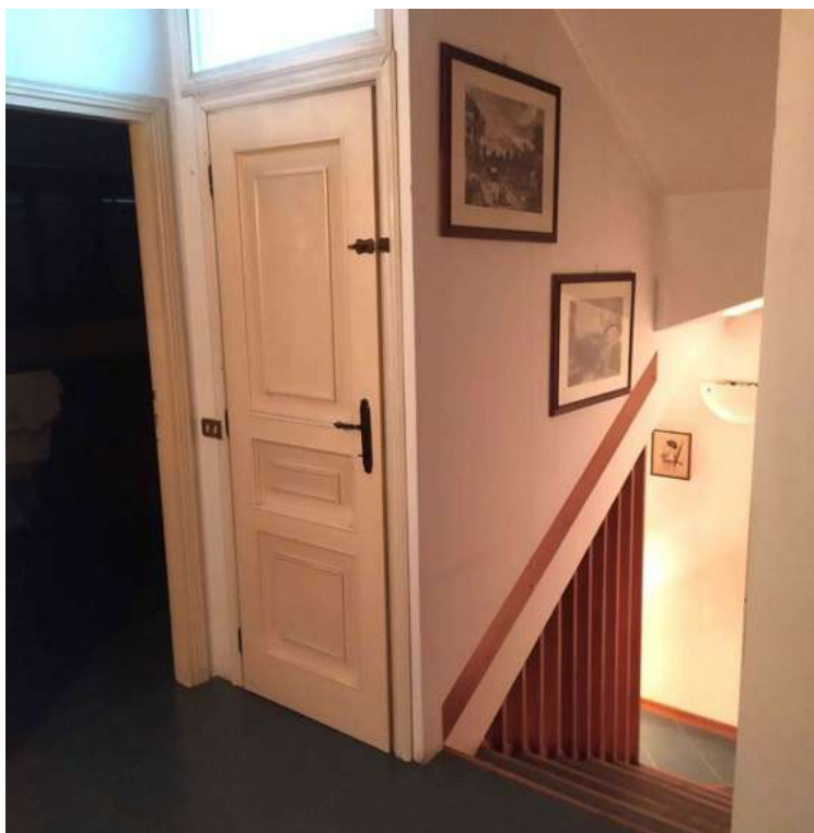
Fotografia C.1 - piano primo - dal locale disimpegno con vista sul vano scala dove si distinguono la porta ed il tamponamento della rampa al piano secondo/sottotetto
