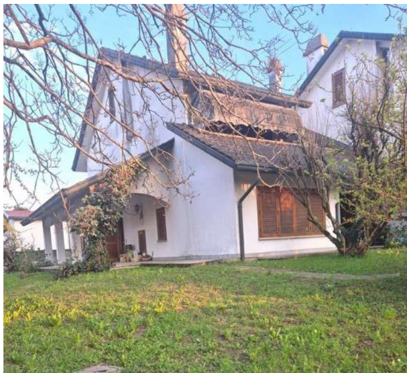
Fotografia C.21 - lato nord/ovest casa e giardino
