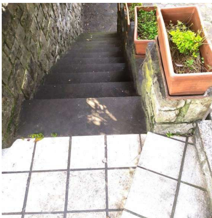
Fotografia C.6 - scala esterna che dal cortile interno conduce al ballatoio di distribuzione insistente sugli spazi pertinenziali di proprietà dell'altra unità (bifamiliare)
