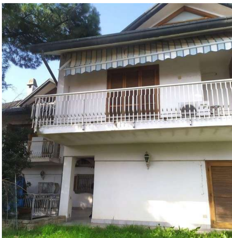
Fotografia C.10 - lato est con vista sulla porzione sud fronte cortile
