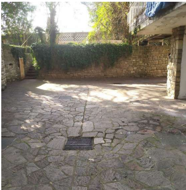
Fotografia C.4 - vista sul cortile di proprietà dell'unità "gemella" sul quale sono visibili la griglia di convogliamento delle acque meteoriche ed il chiusino della fossa settica comune alle due unità
