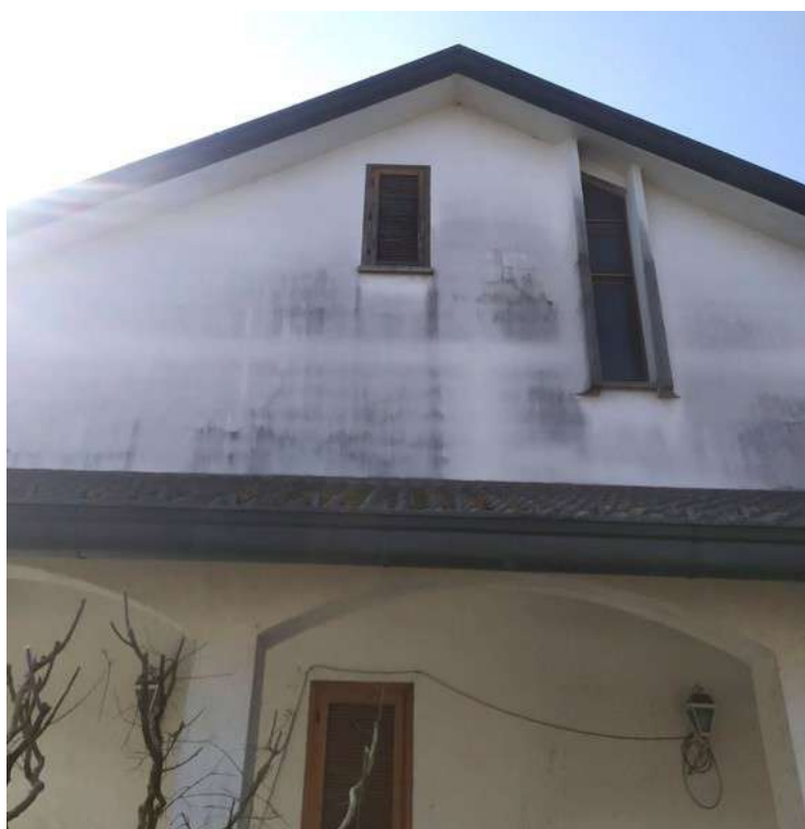
Fotografia C.20 - scorcio lato nord sotto la cuspide sulla sinistra la finestra del bagno sottotetto e sulla destra la finestra del vano scala
