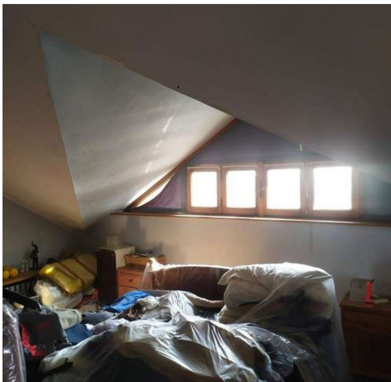
Fotografia C.17 - abbaino locale sottotetto
