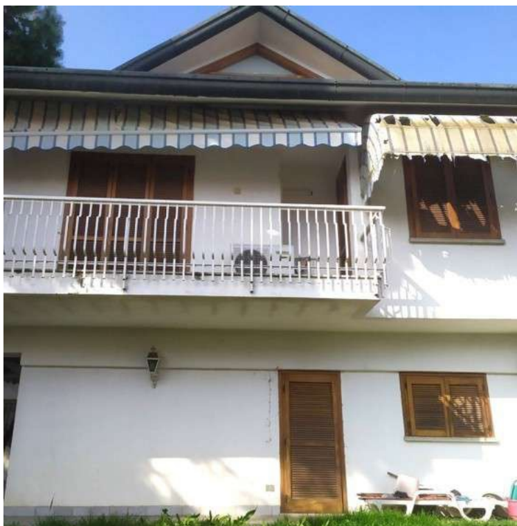
Fotografia C.9 - lato est al piano terra la porta finestra del tinello e della cucina ed al piano primo sul balcone è visibile l'unità esterna dual split alle servizio delle due camere
