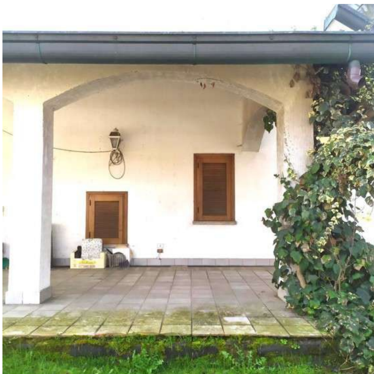
Fotografia C.3 - lato nord - porzione ovest del portico con vista su finestra locale soggiorno (prima a destra) e vano scala piano interrato
