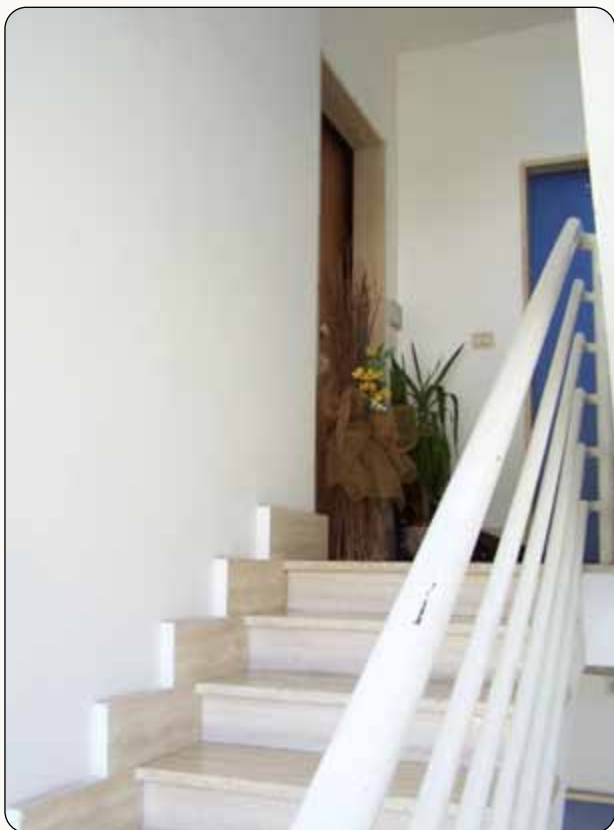
Vista interna della scala condominiale
