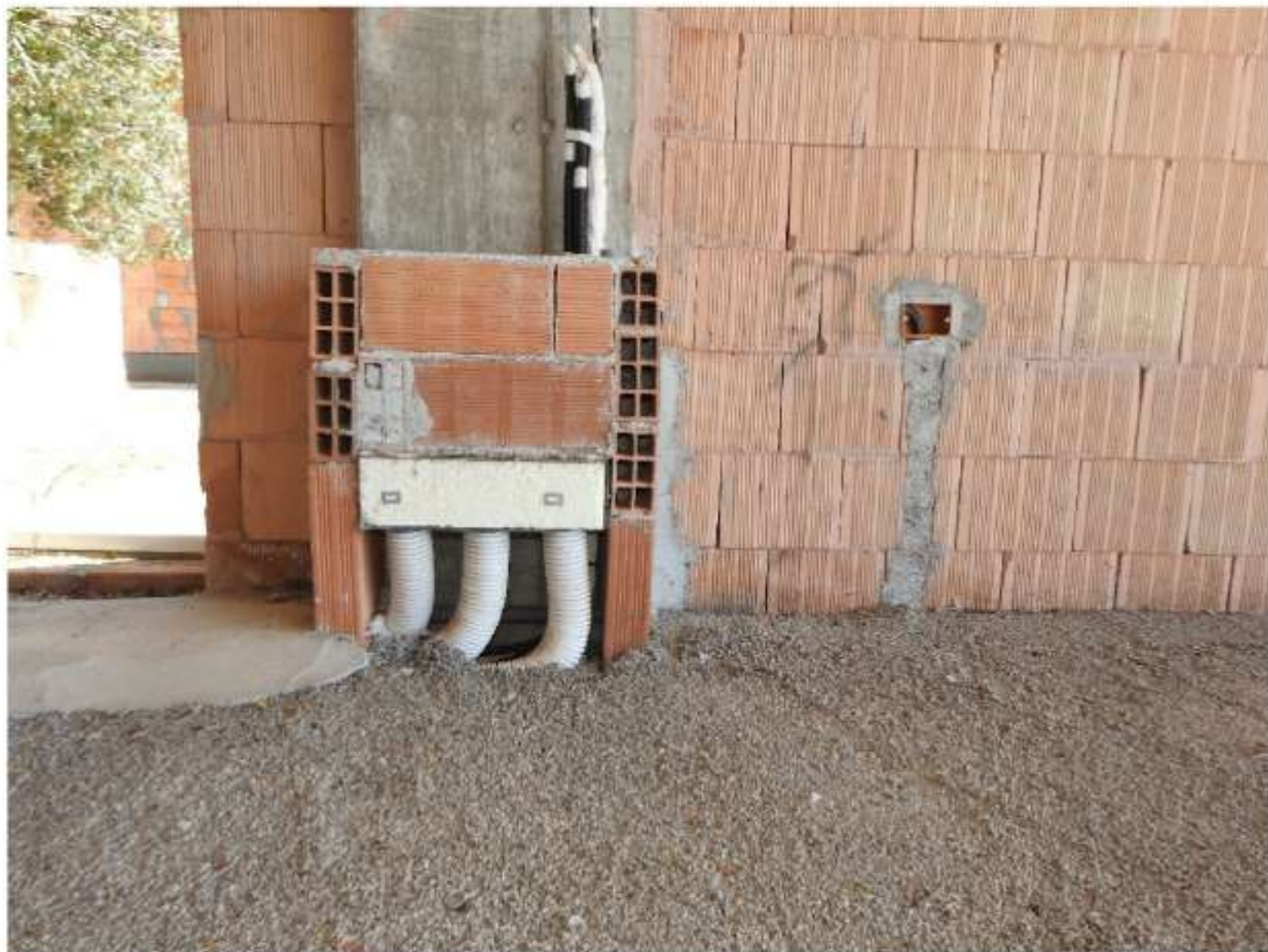
Foto 2 - Predisposizione dell'impianto elettrico e delle linee tecnologiche/dati, costituita da tubazioni corrugate sottopavimento, montante verticale in corrispondenza del pilastro, muretto tecnico in laterizio e cassetta da incasso a parete per la futura distribuzione dei collegamenti a servizio della sala lettura.
