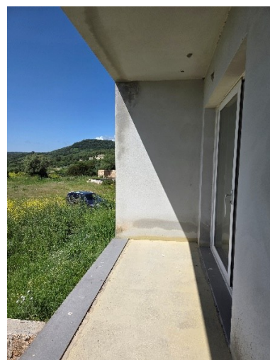
Figura 30 - Balcone tipo, piano terra
