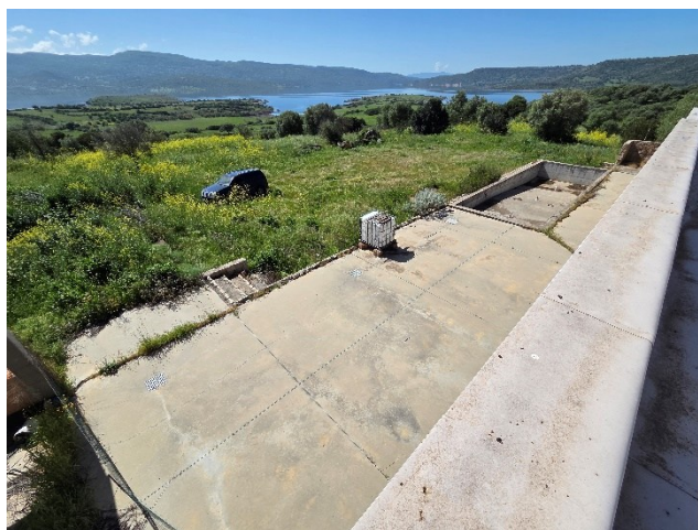
Figura 11 - Vista dal tetto dell'unità bar -ristorante
