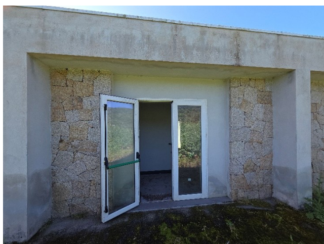
Figura 24 - Unità residenziali, ingresso piano terra
