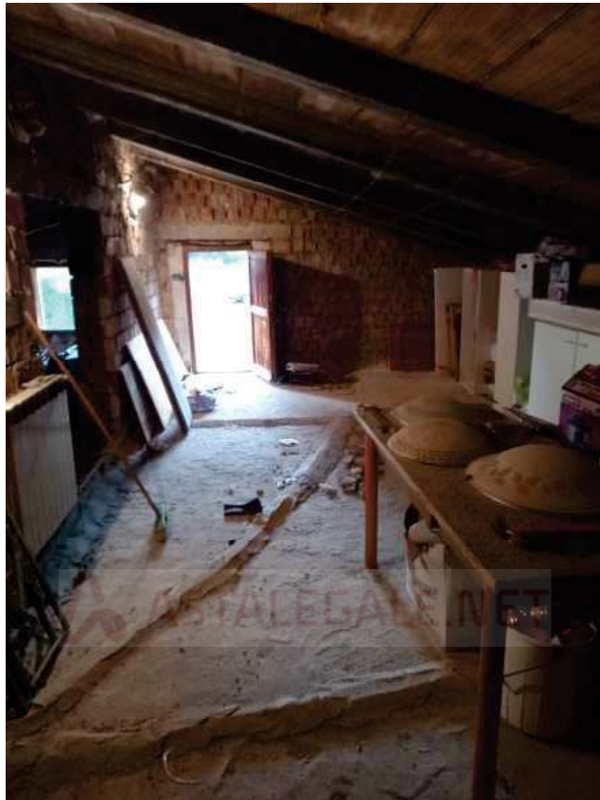
Vista Soffitta Piano Sottotetto
