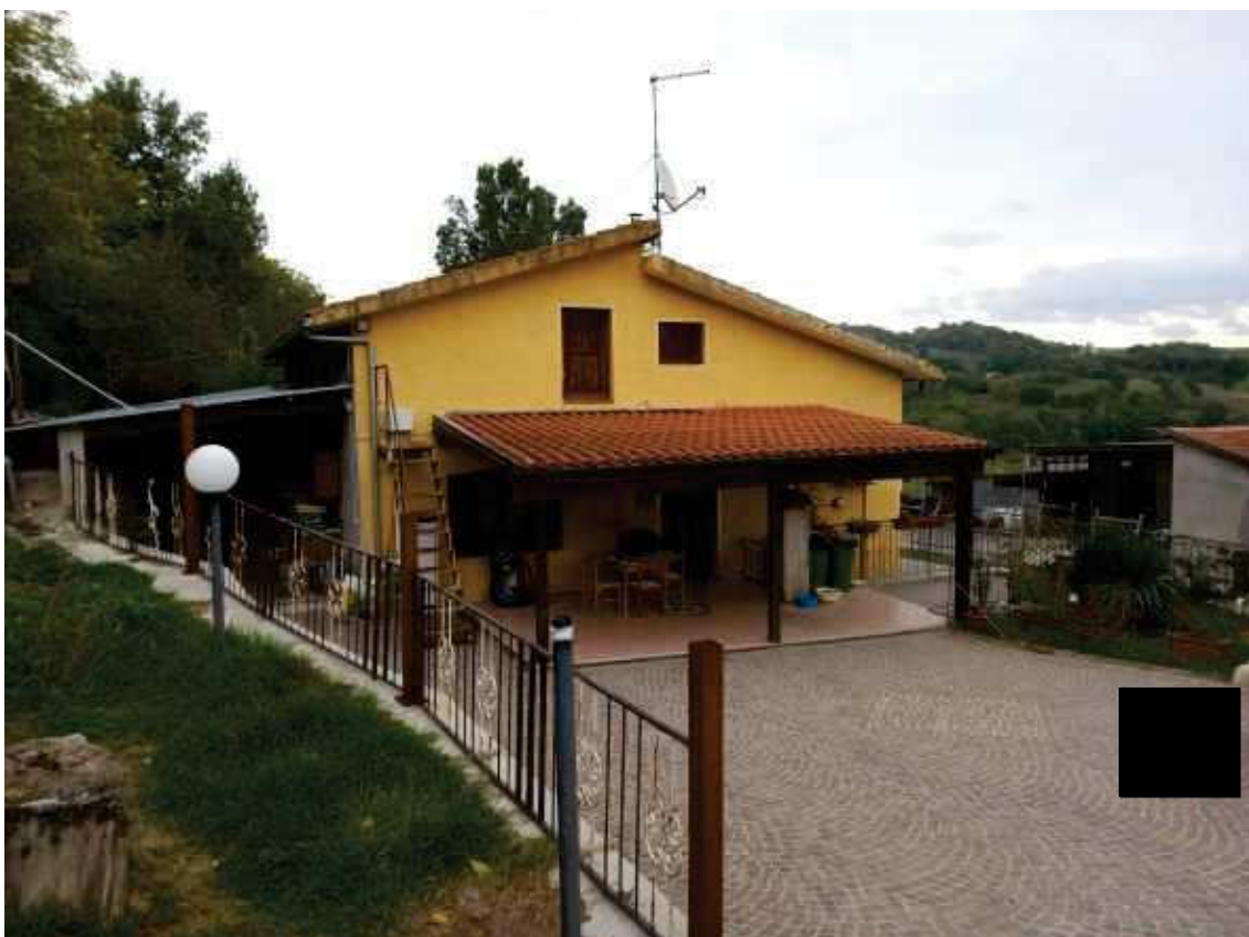
Vista da lato Strada Provinciale n. 46
