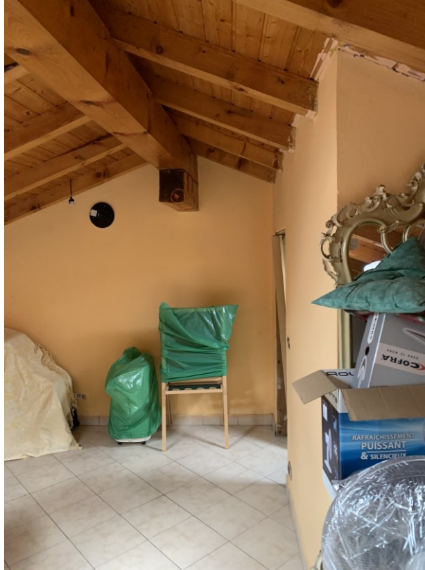
Foto n. 7 P. 2 – Ambiente sottotetto
