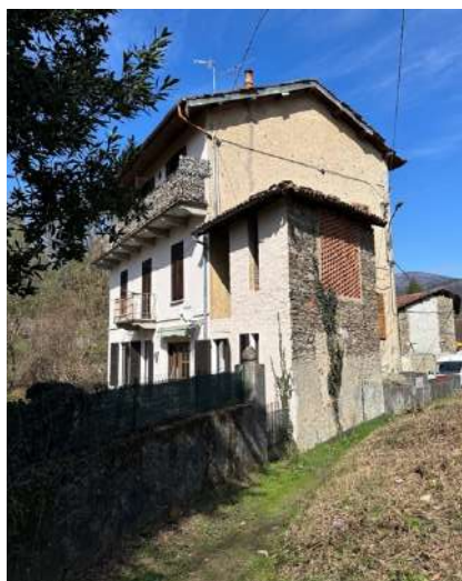
Foto 5 – prospetto fabbricato lato sud-est
